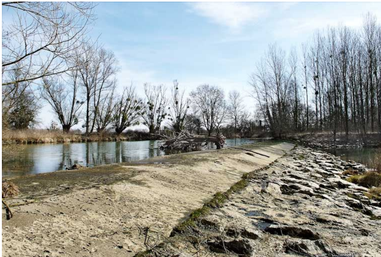
Barrage lié aux moulins de Branges. Traces d'un ancien alignement d'arbres. 71, Branges, lieudit : La Culée
