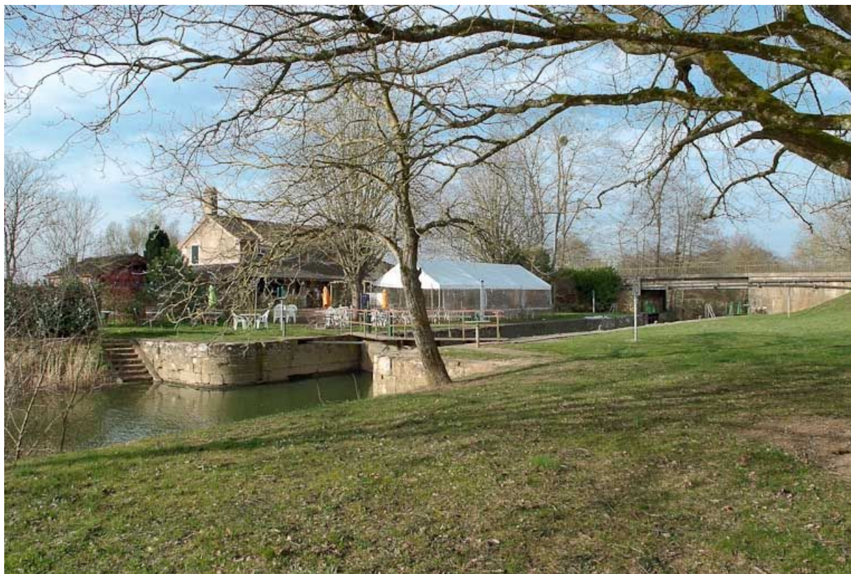
Ensemble du site de l'écluse de Branges, vu d'amont.
