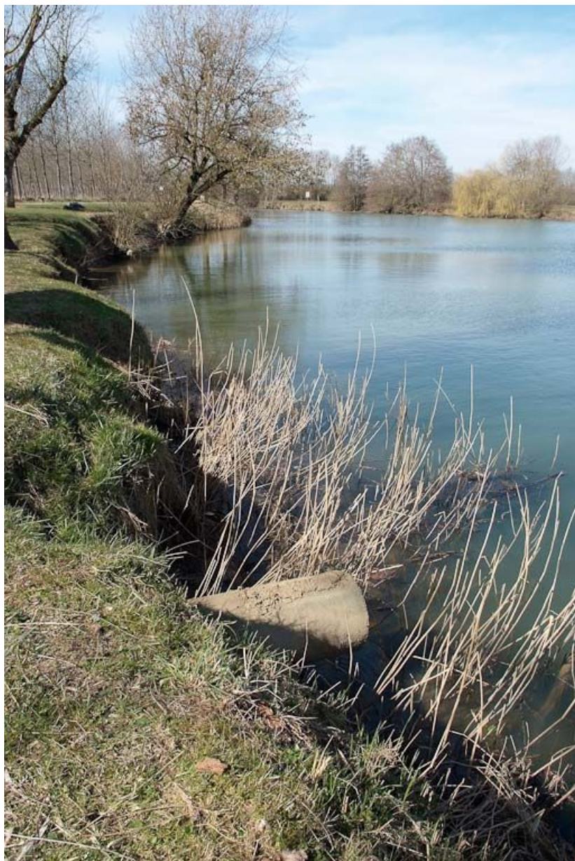
Aqueduc de l'Ecolier, rive gauche de la Seille, vu d'amont. 71, Louhans
