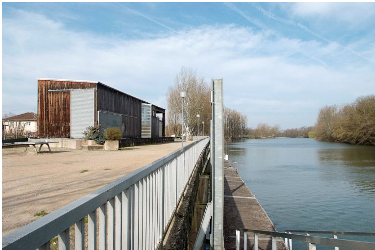
Port de Louhans. A gauche, la capitainerie, vue d'aval. 71, Louhans
