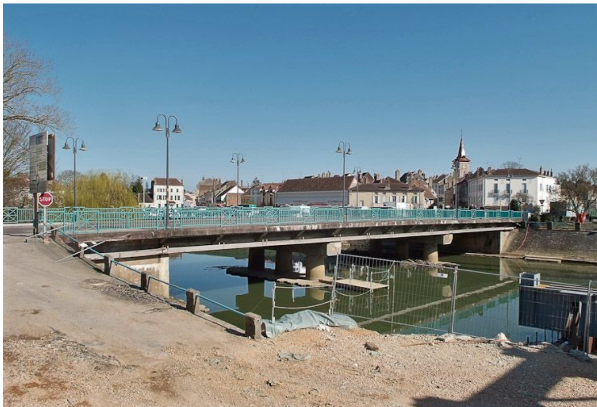
Pont routier sur la Seille, vue d'aval.
