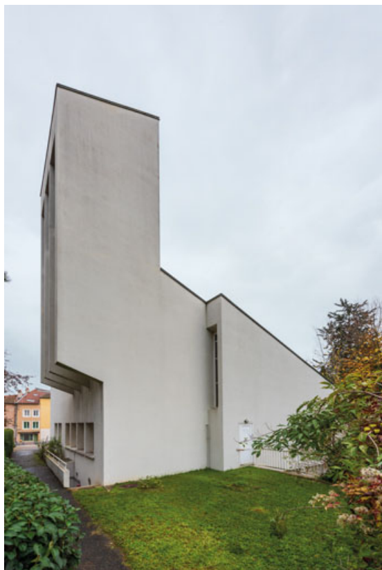
Vue de la façade ouest.
