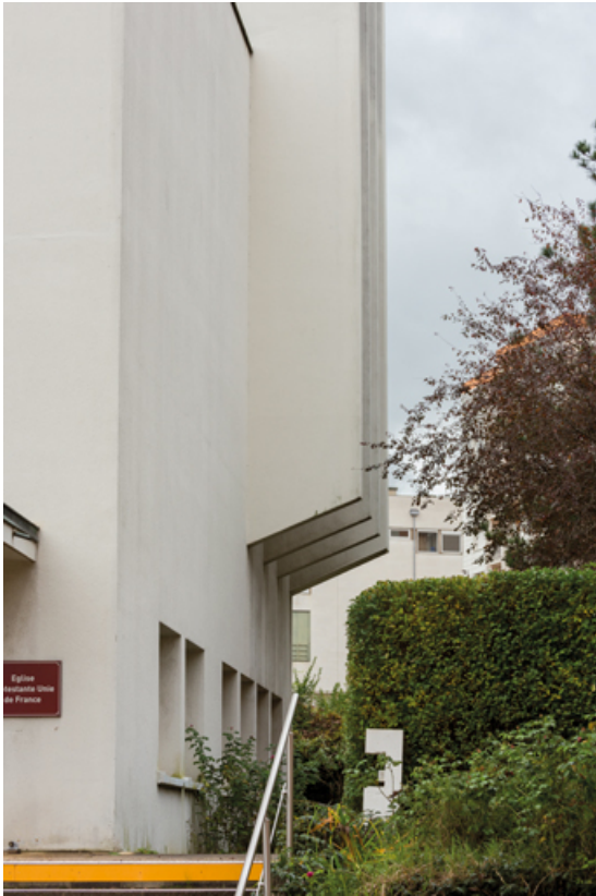
Détail de la façade nord et de la base en saillie du clocher. 71, Mâcon, 32 rue Saint-Antoine
