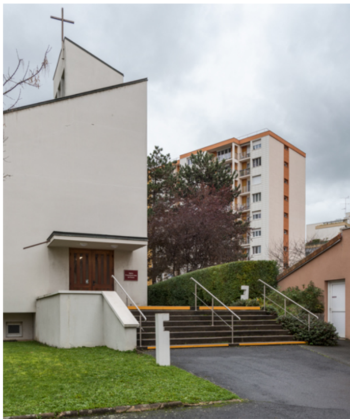
Vue d'ensemble du parvis. En retrait, un immeuble à logements du programme urbain du plateau de la Baille. 71, Mâcon, 32 rue Saint-Antoine
