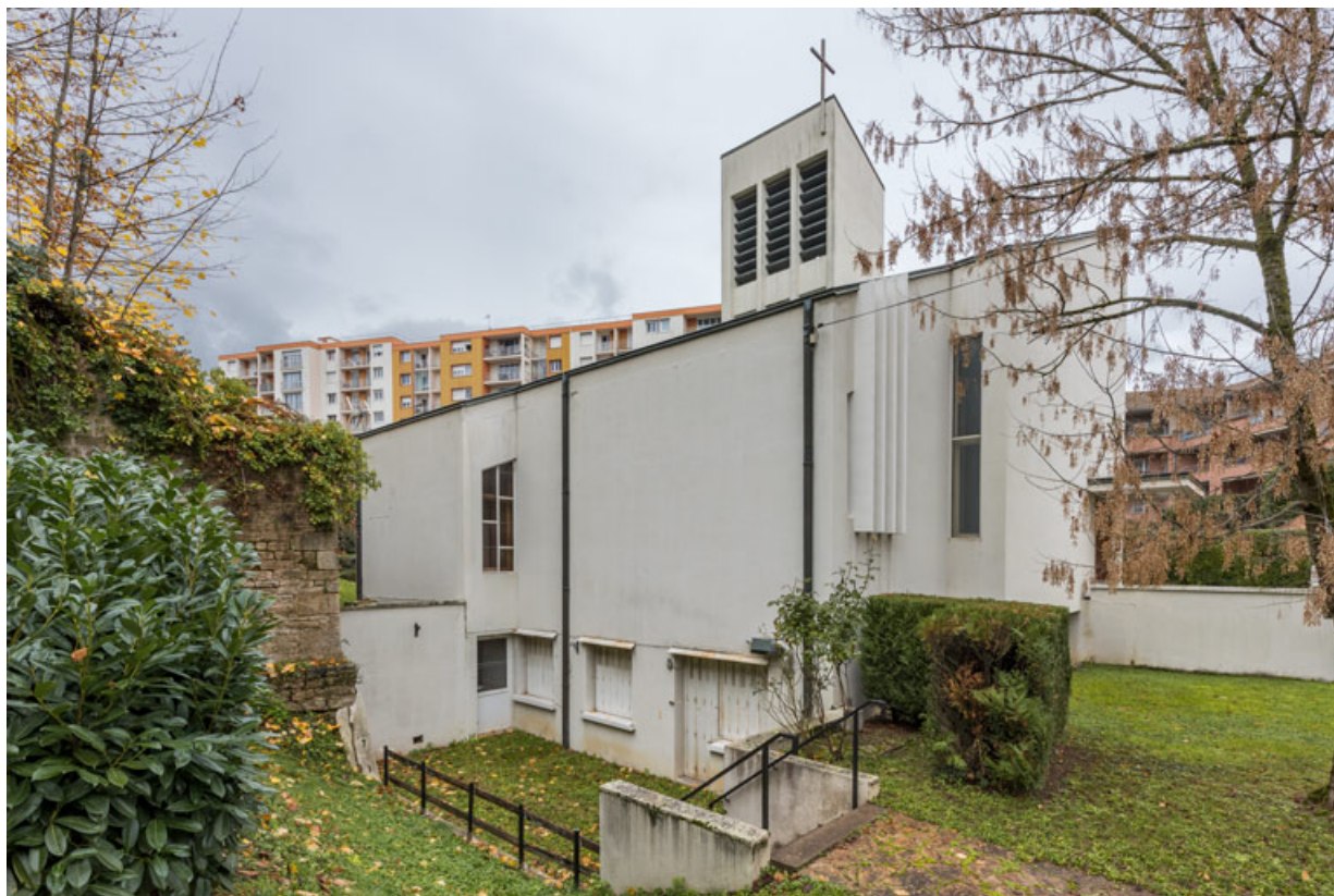
Vue de la façade sud (de trois-quarts).
