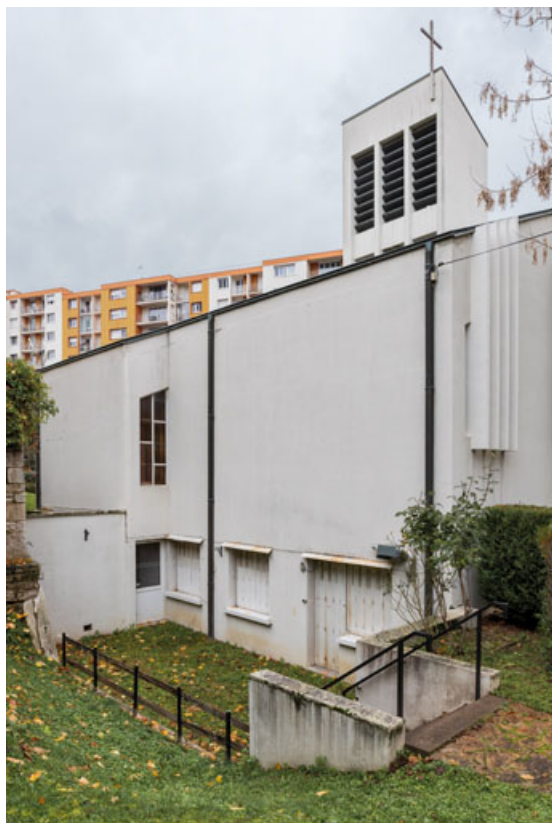
Vue de la façade sud et de son étage de soubassement abritant le logement du gardien. 71, Mâcon, 32 rue Saint-Antoine
