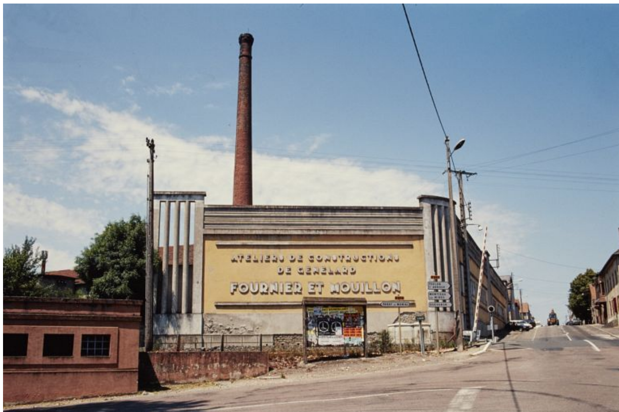
vue générale du mur sur le long de la voie de chemin de fer et de la rue Nationale.
