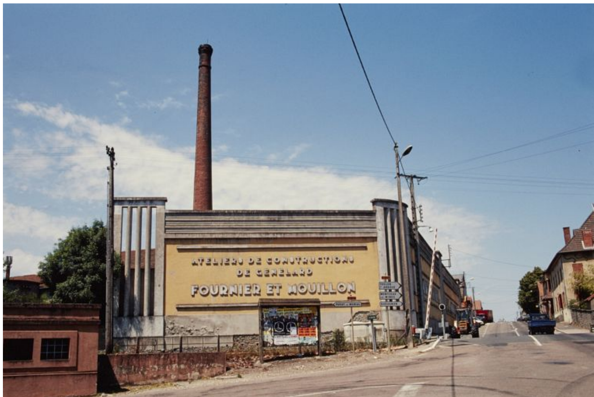
vue générale du mur sur le long de la voie de chemin de fer.
