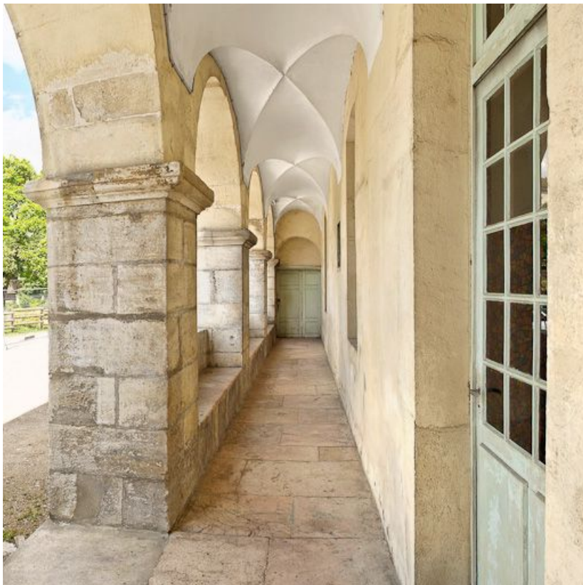
Bâtiment en L, vue de la galerie nord.
