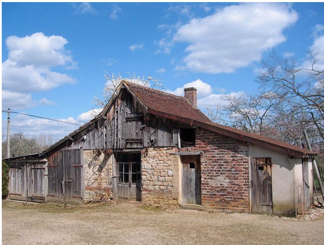
Vue d'ensemble de la façade de l'atelier-four.
