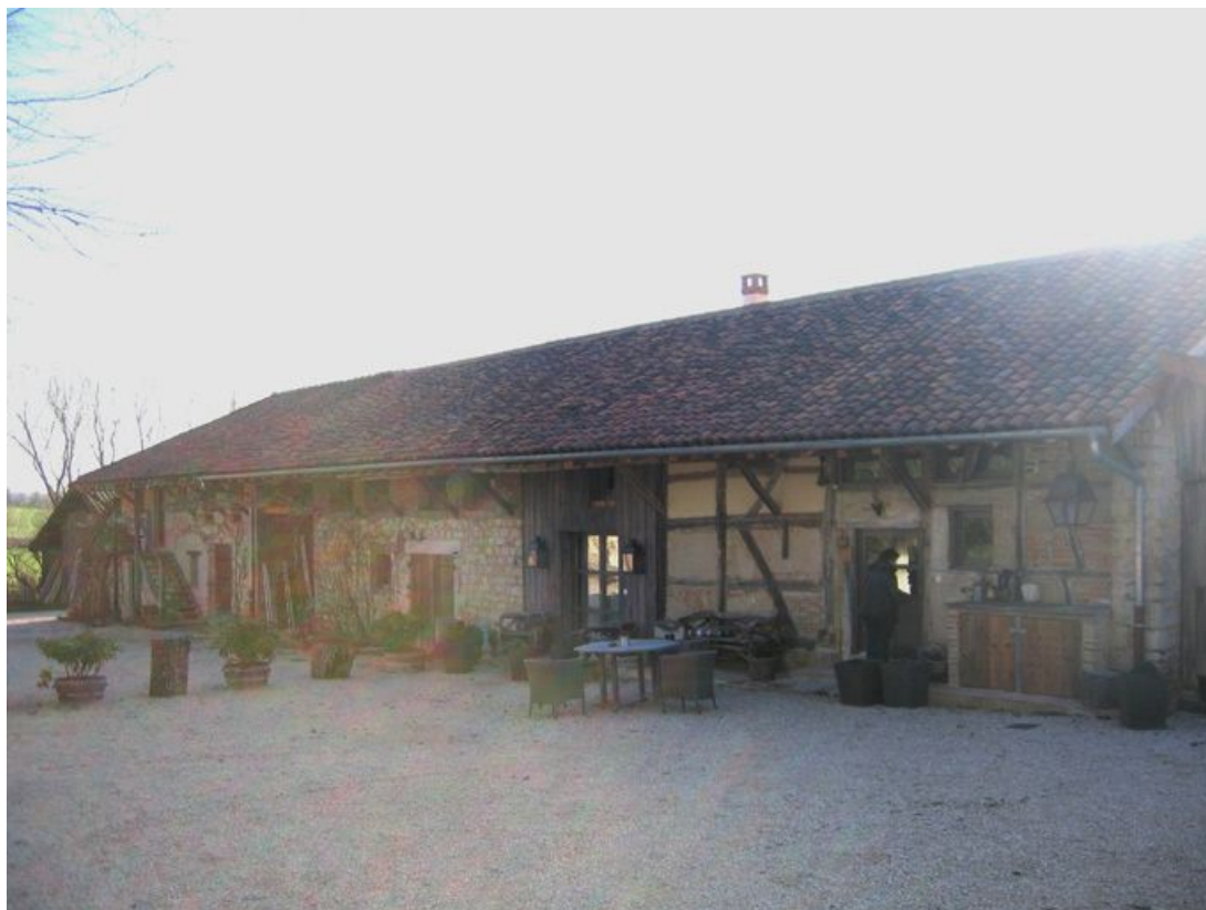
Vue d'ensemble de la façade du bâtiment des dépendances.
