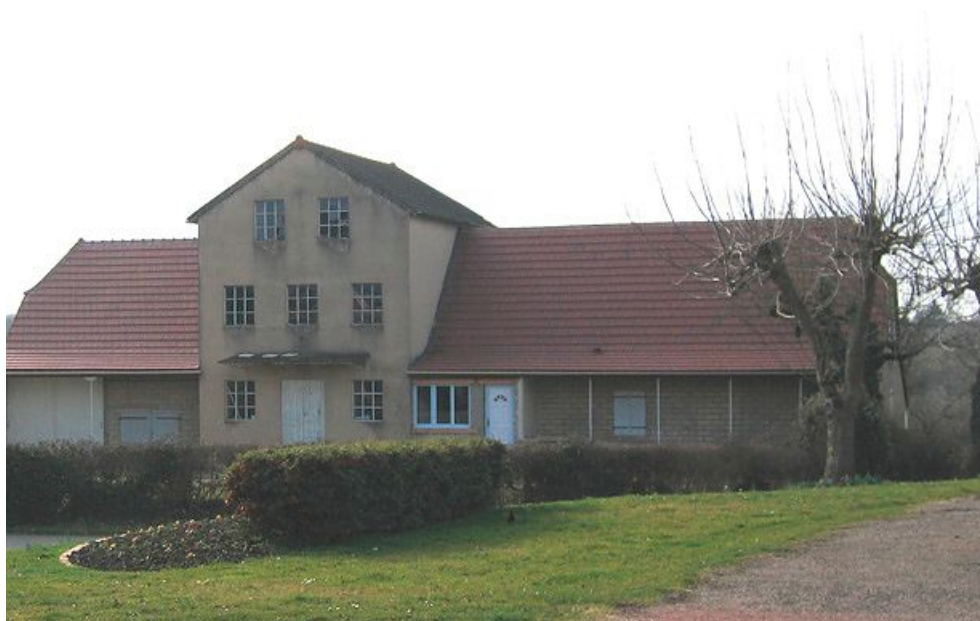
Vue d'ensemble de la façade du moulin.
