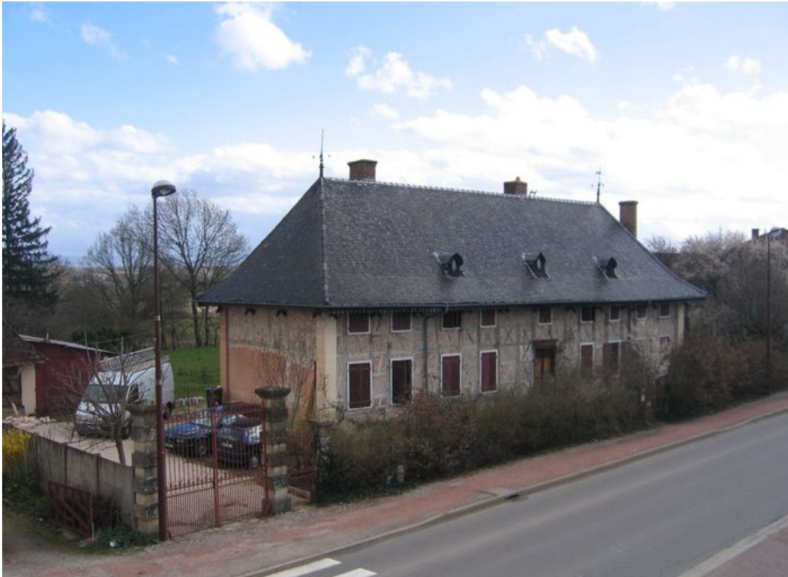
Vue d'ensemble de la façade.
