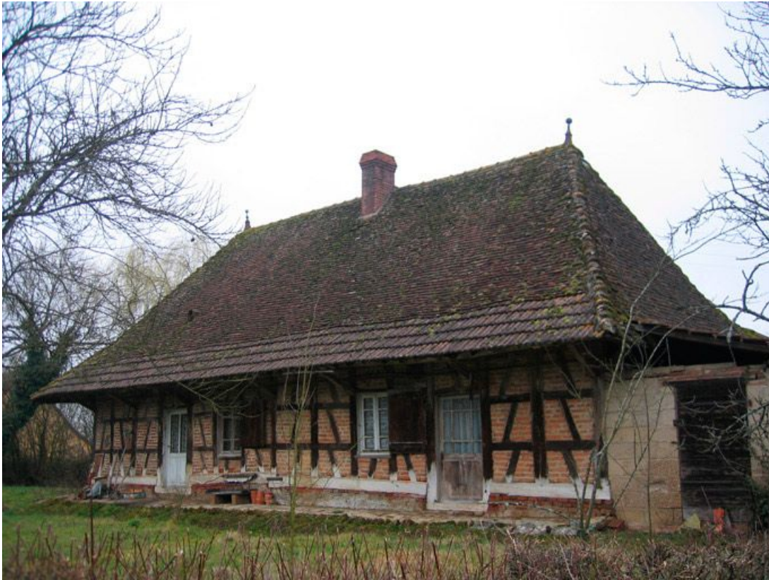
Vue d'ensemble de la façade postérieure de la maison.
