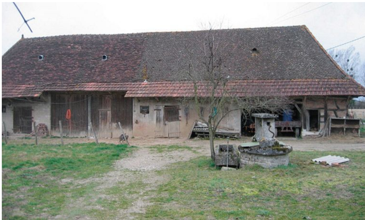
Vue d'ensemble de la façade du bâtiment des dépendances.
