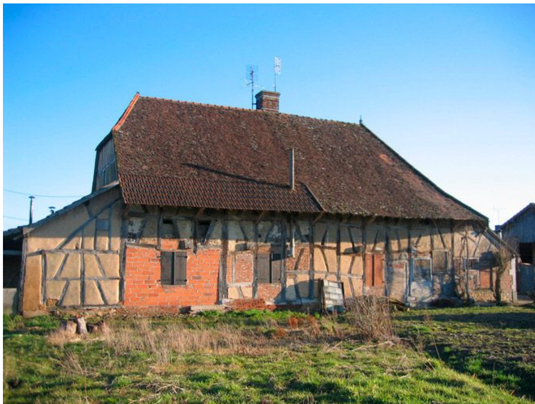
Vue d'ensemble de la façade postérieure.
