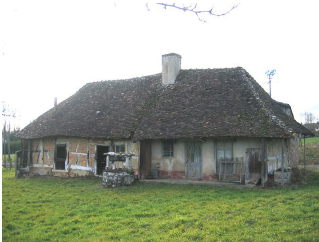
Vue d'ensemble de la façade.
