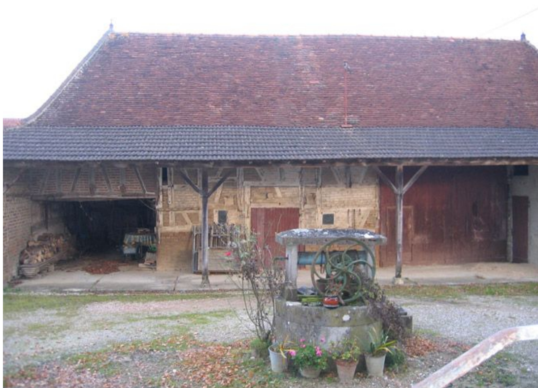
Vue d'ensemble de la façade du bâtiment des dépendances.
