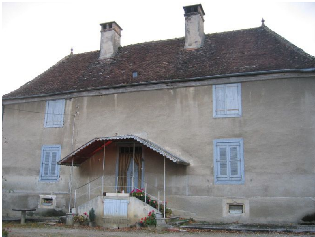
Vue d'ensemble de la façade de l'habitation.
