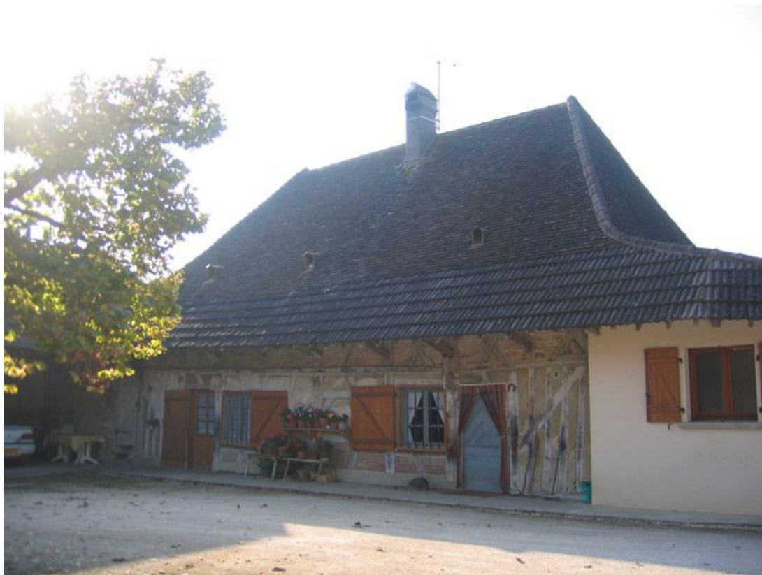
Vue d'ensemble de la façade de l'habitation.
