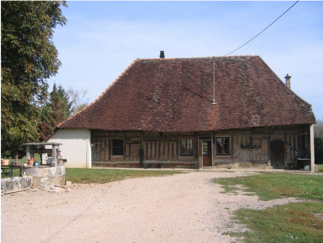
Vue d'ensemble de la façade.
