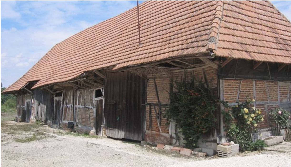
Vue d'ensemble de la façade du bâtiment des dépendances.
