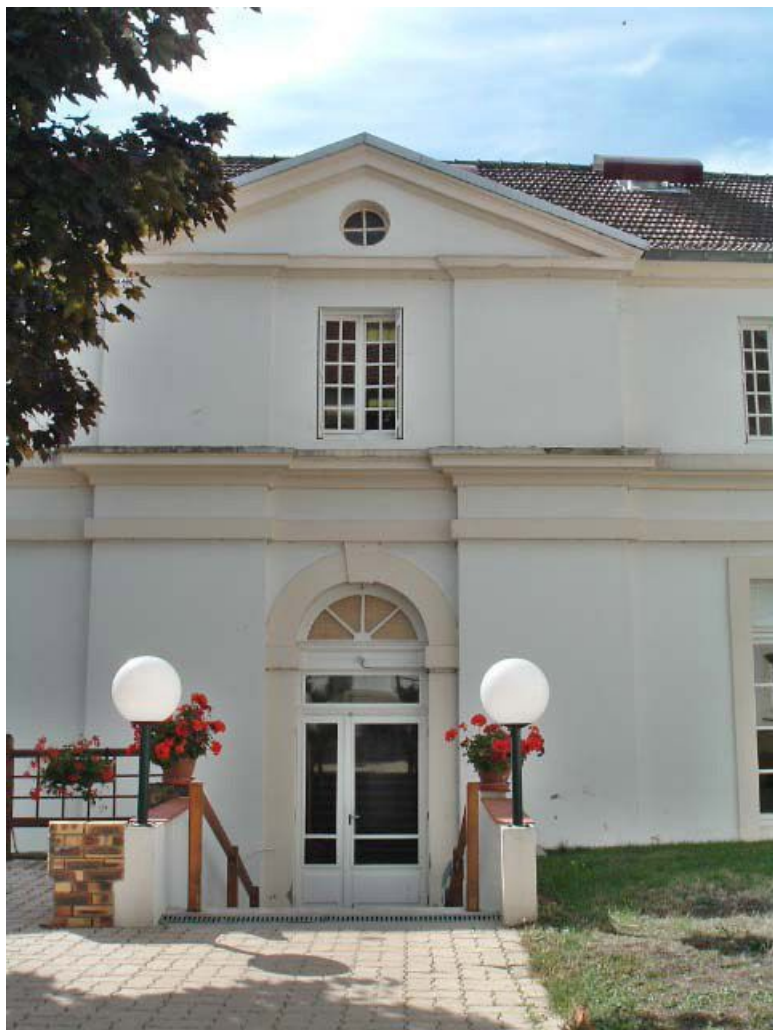
Bâtiment Dalivert (1781-1784), vue rapprochée de la façade antérieure, avant-corps central. 71, Montcenis Eglise
