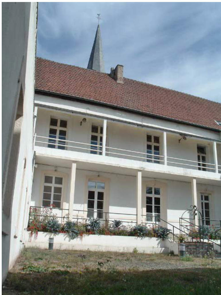
Bâtiment ancien Caristie (vers 1752), façade postérieure sur le jardin (remaniée) et galerie de liaison contemporaine. 71, Montcenis Eglise
