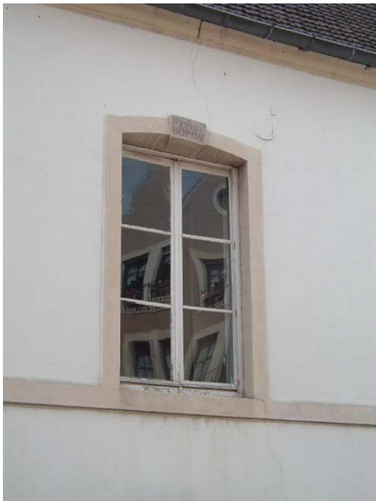
Bâtiment Caristie (vers 1752), vue de détail de la façade antérieure, fenêtre portant l'inscription JHS, HOPITAL. 71, Montcenis Eglise
