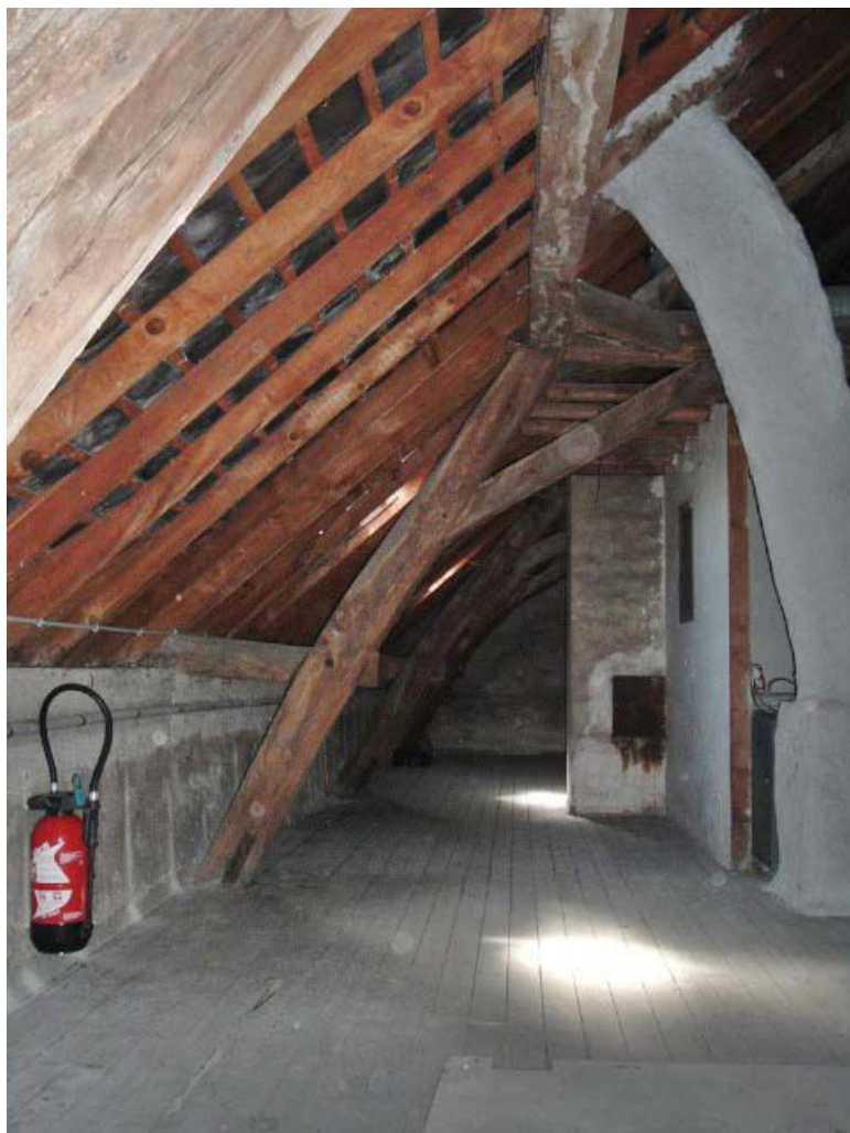
Vue intérieure des pannes de la charpente, comble.
