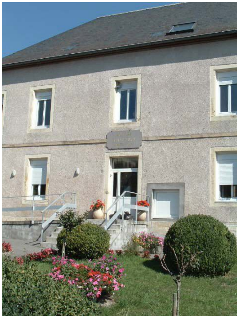
Vue de détail de la façade antérieure du bâtiment d'origine.
