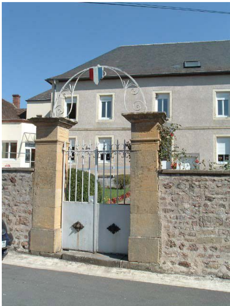
Portail d'entrée du bâtiment d'origine, vue de détail.
