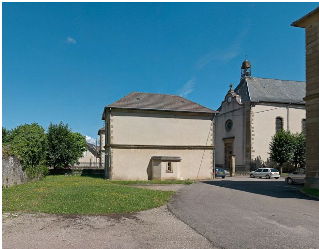
Bâtiment à droite de l'allée et chapelle. 71, Autun, 9 boulevard Frédéric-Latouche
