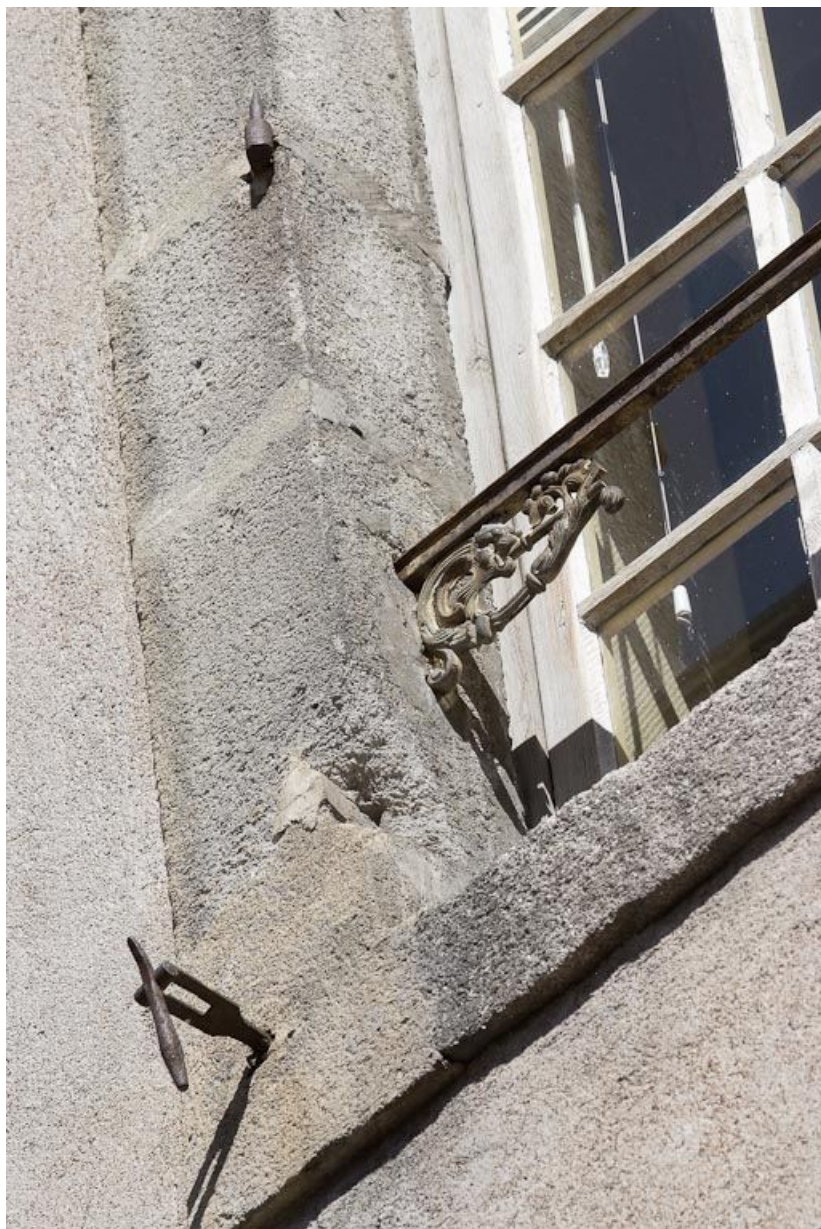
Pavillon postérieur de l'aile droite : détail d'une fenêtre.
