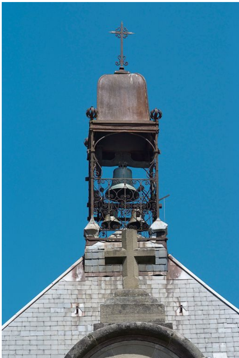
Campanile et croix du fronton de la chapelle.
