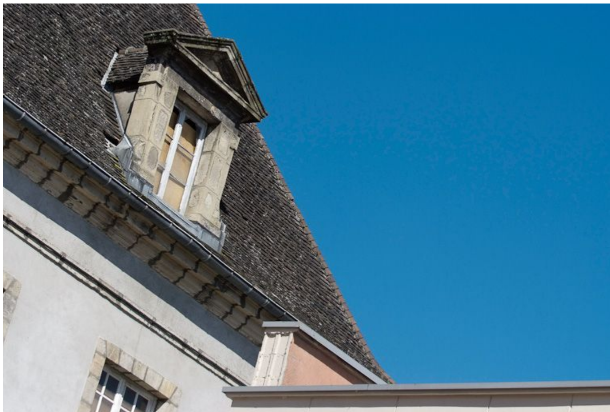
Aile gauche, lucarne du pavillon postérieur. 71, Autun, 9 boulevard Frédéric-Latouche
