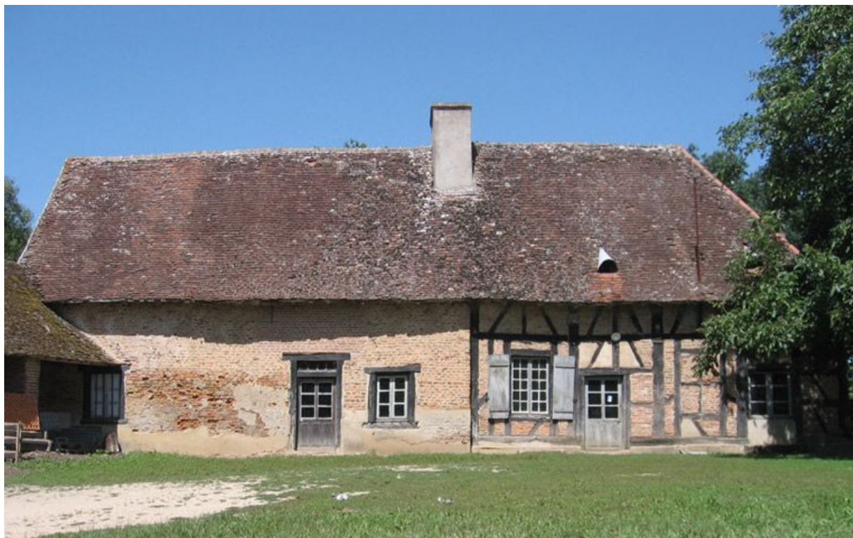
Vue d'ensemble de la façade de l'habitation.
