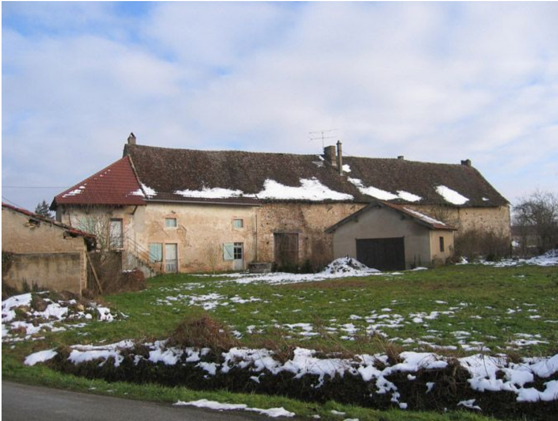
Vue d'ensemble de la façade postérieure. 71, L'Abergement-de-Cuisery
