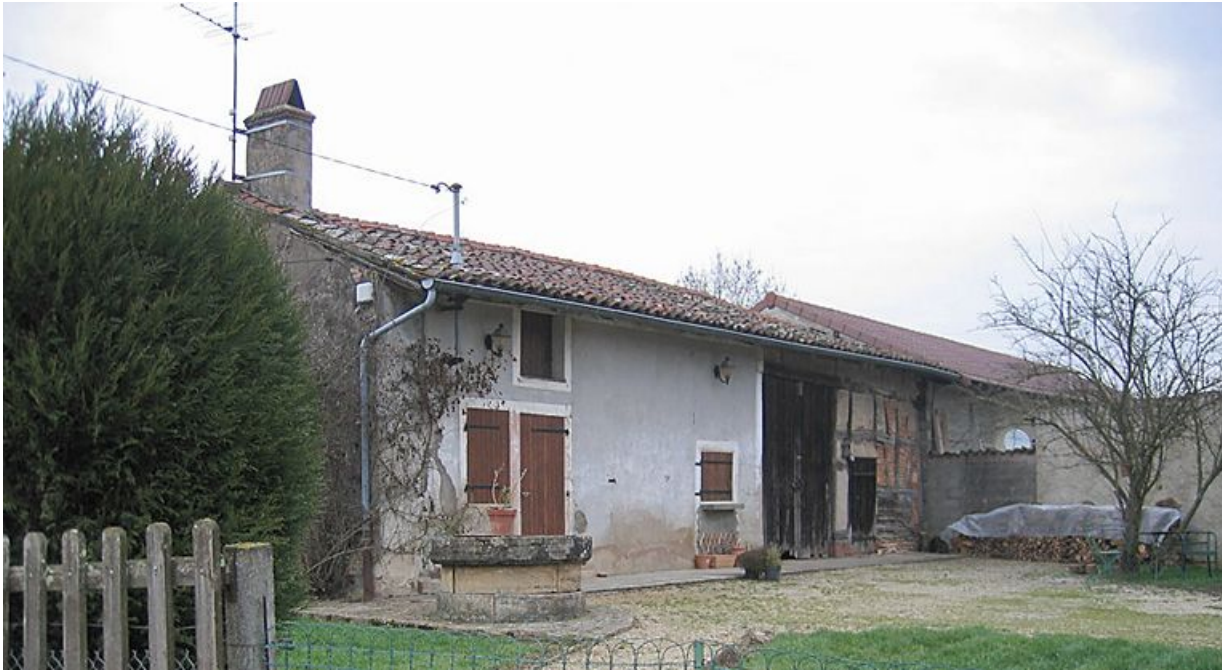
Vue d'ensemble de la façade.
