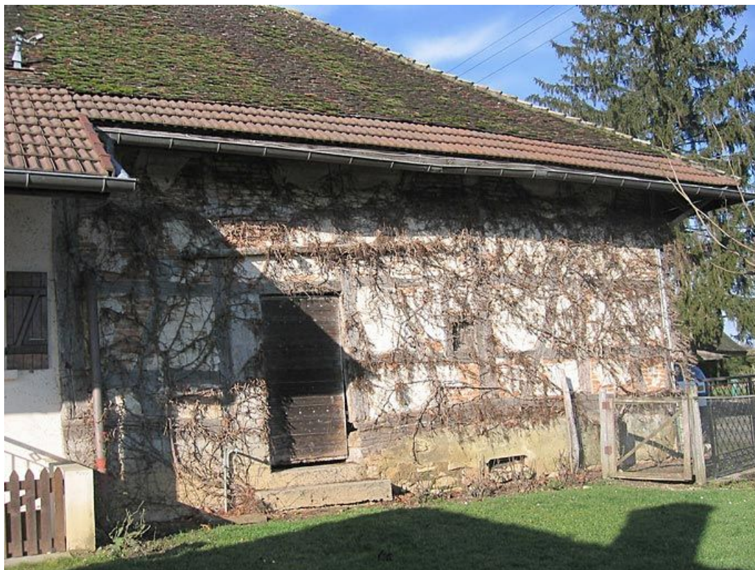
Vue d'ensemble de la façade.
