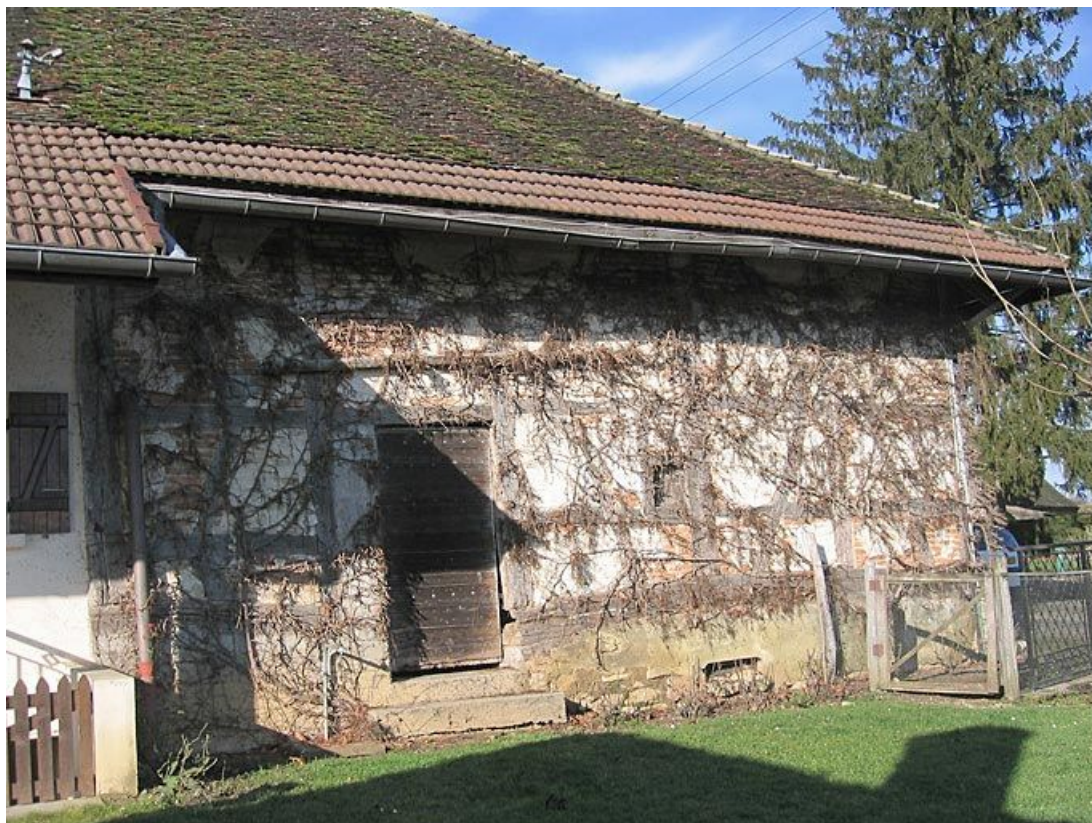
Vue d'ensemble de la façade.
