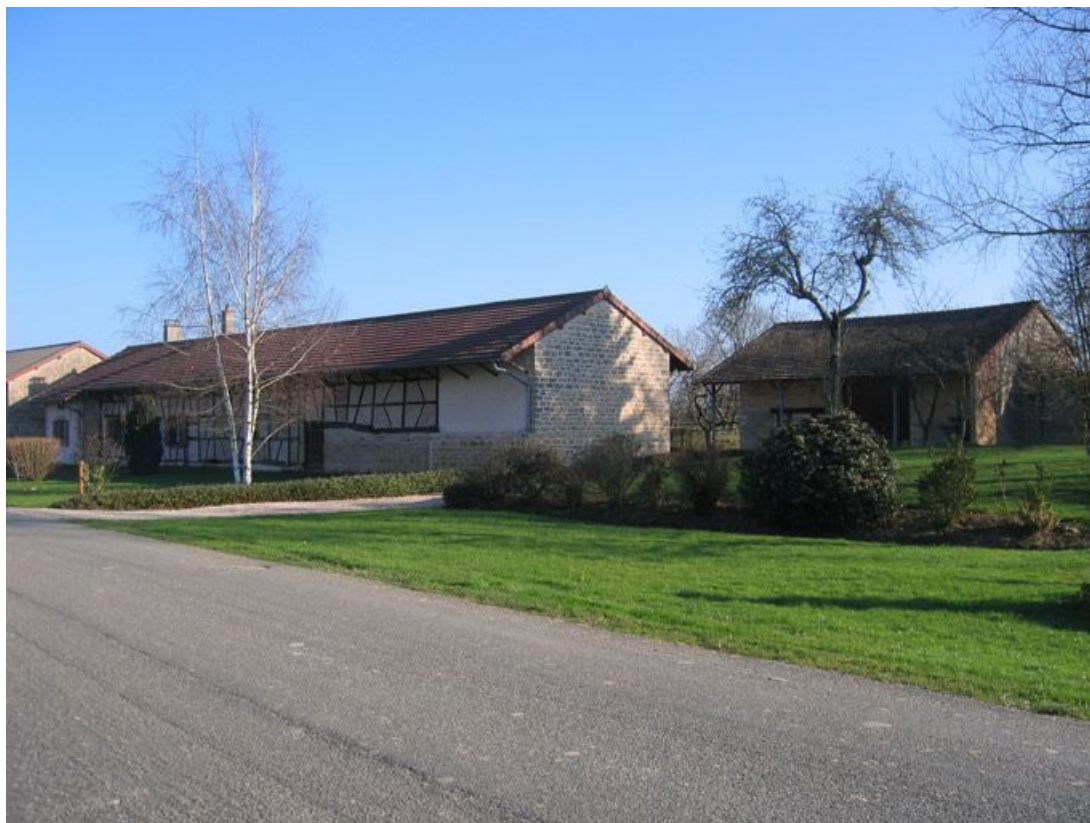
Vue d'ensemble de la façade.
