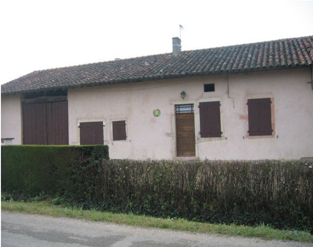
Vue d'ensemble de la façade antérieure.
