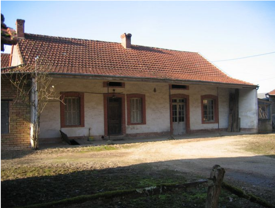
Vue d'ensemble de la façade.
