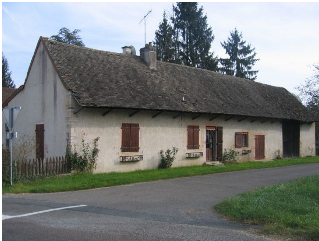
Vue d'ensemble de la façade.
