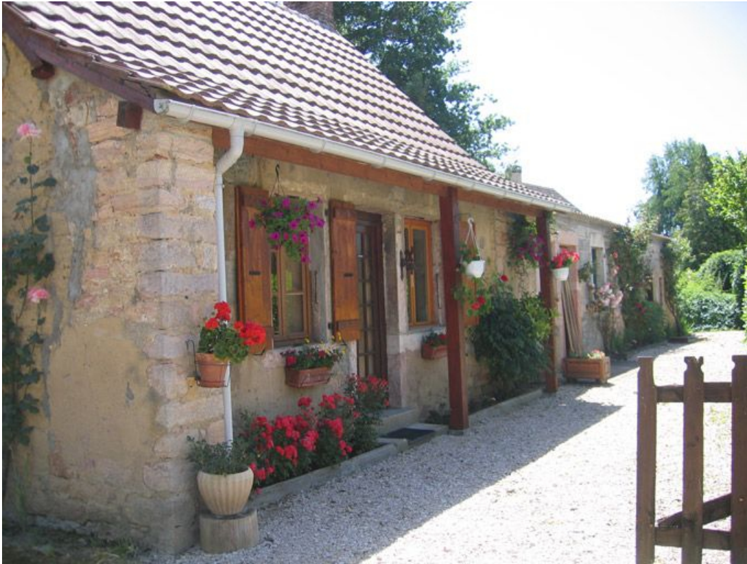
Vue d'ensemble de la façade.
