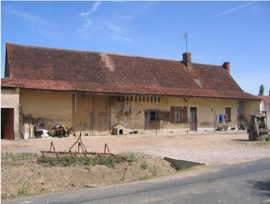
Vue d'ensemble de la façade.
