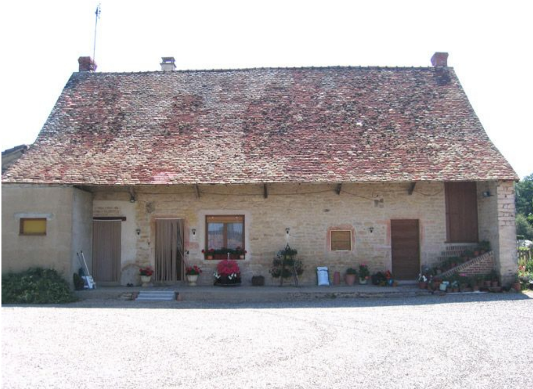
Vue d'ensemble de la façade.
