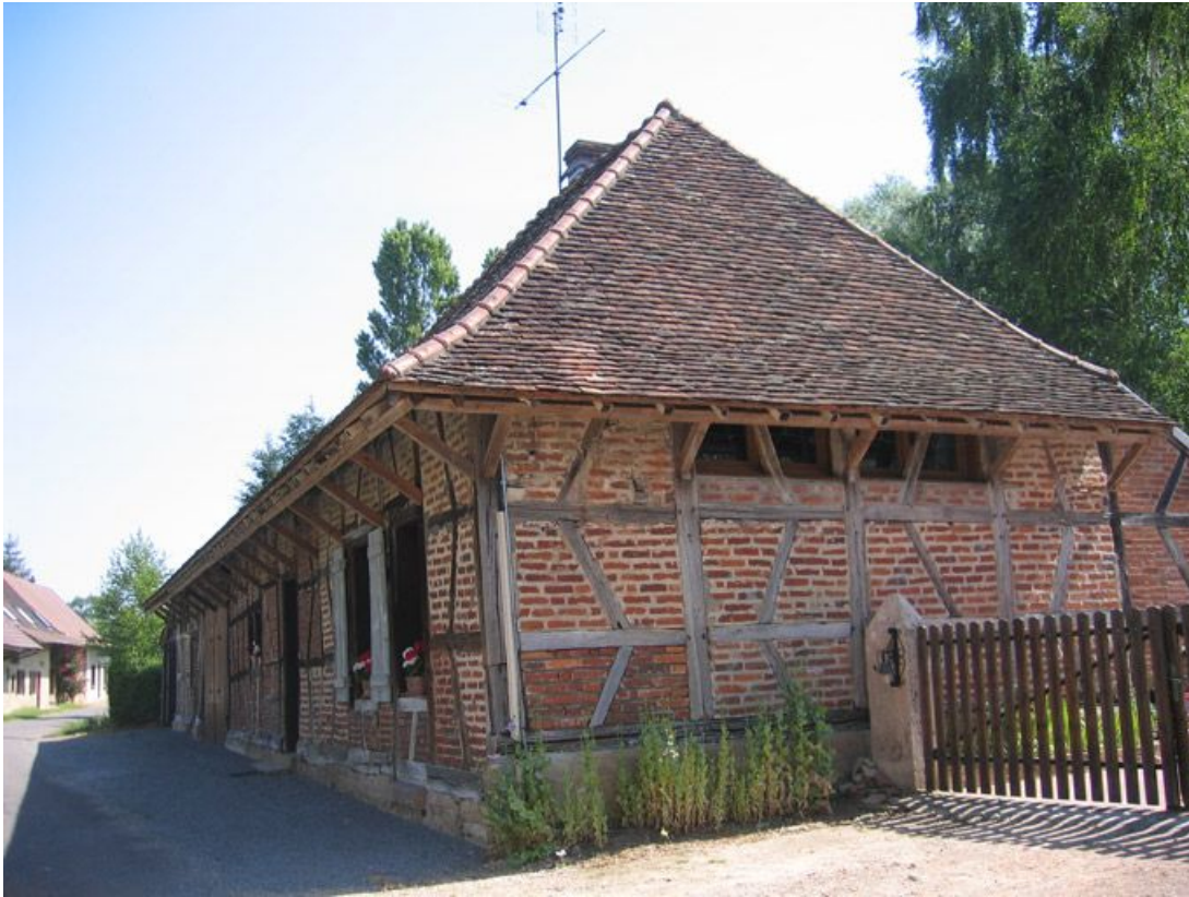
Vue d'ensemble de la façade.
