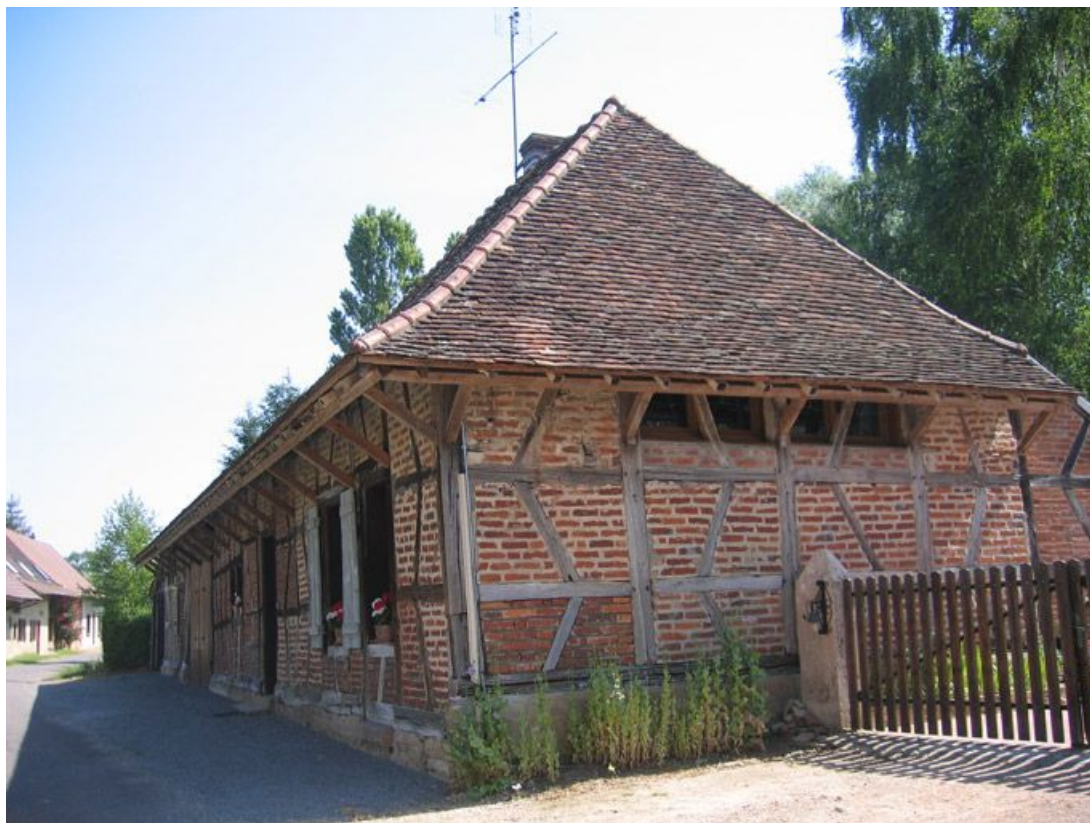
Vue d'ensemble de la façade.
