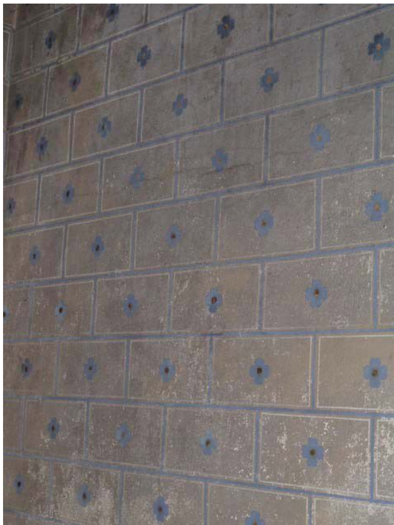
Vue de détail de la peinture murale de l'oratoire (décor polychrome faux joints et fleurette).
