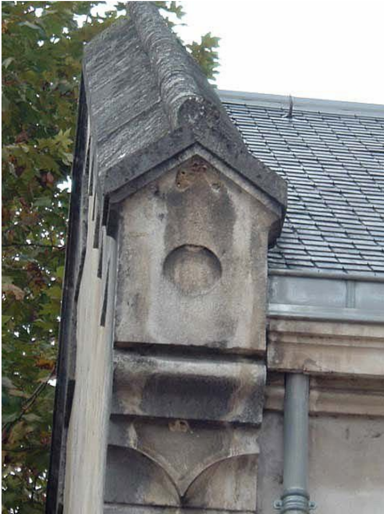
Vue de détail : rampant du pignon découvert.
