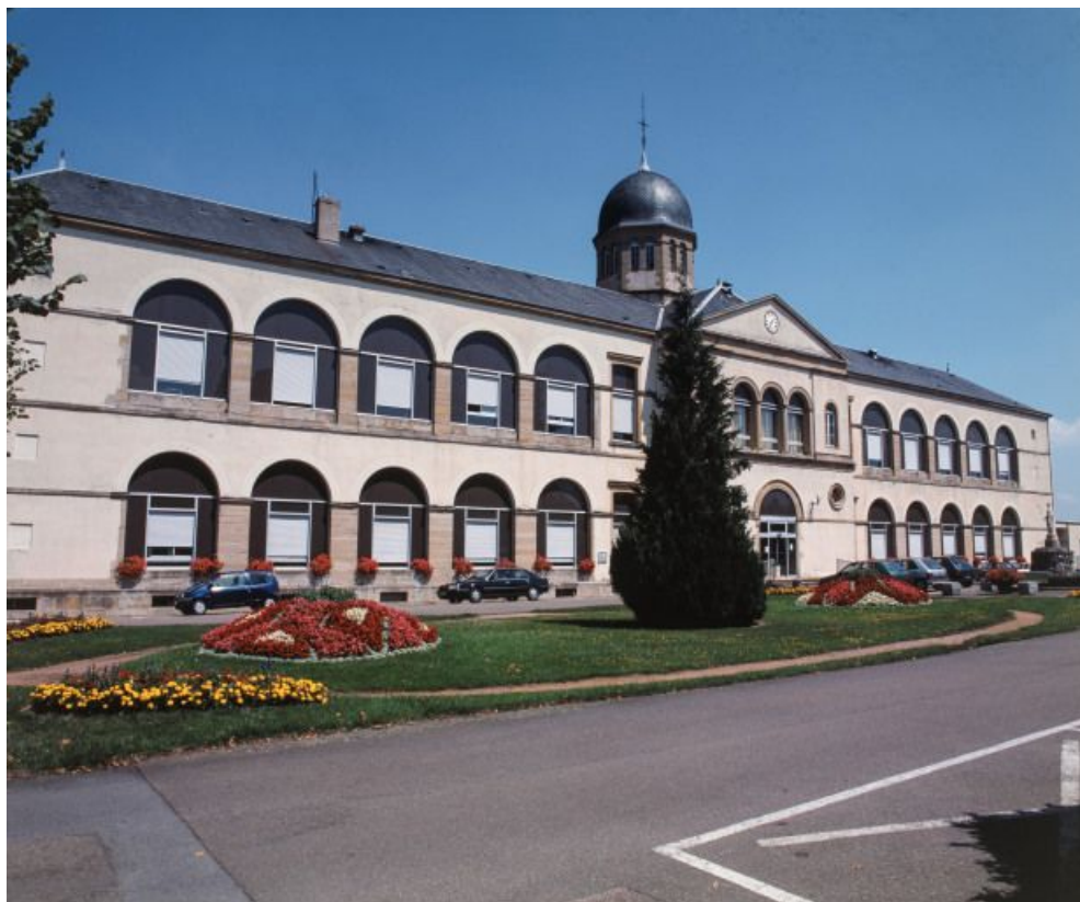
Vue de la façade principale de trois-quarts.
