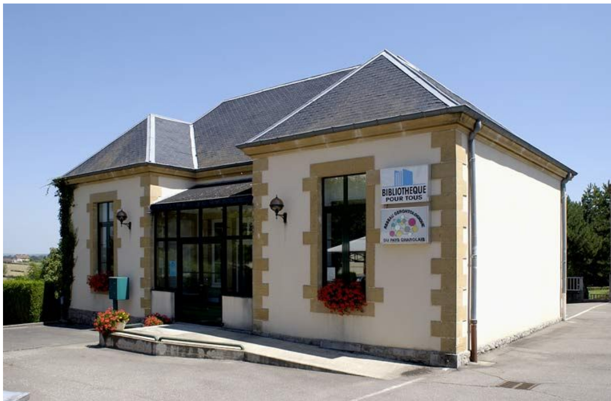
Ancienne maternité, vue d'ensemble.
