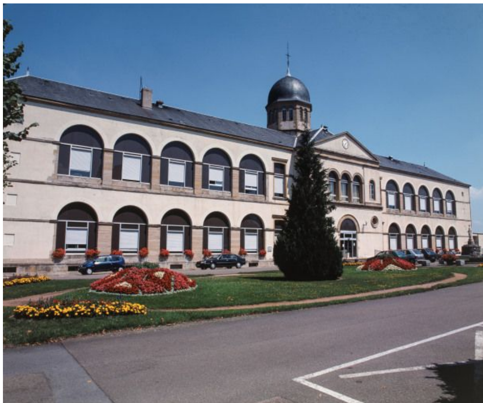
Vue de la façade principale de trois-quarts.
