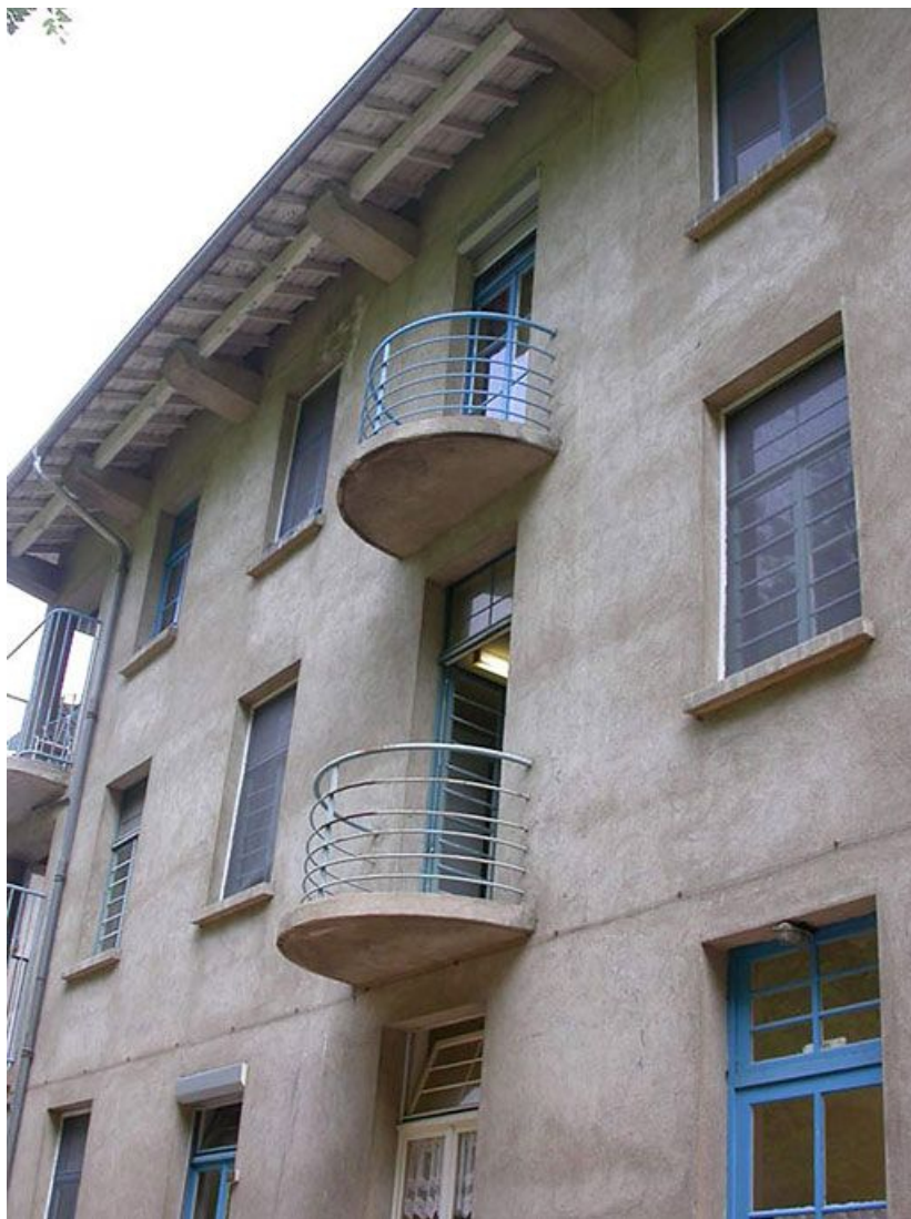
Aile des soins médicaux, façade postérieure : détail des balcons.
