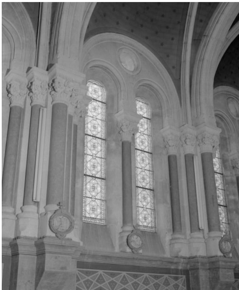
Chapelle, détail d'une baie du bas-côté gauche.
