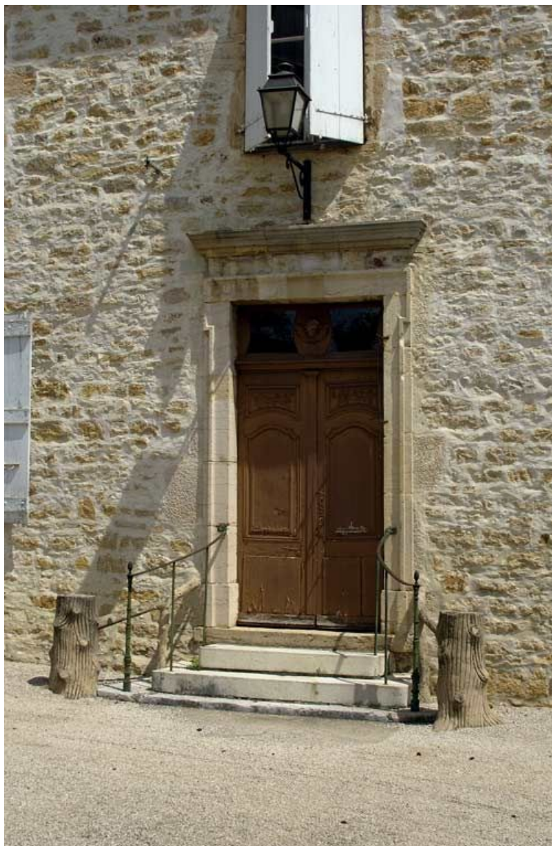
Façade antérieure, détail de l'ancienne porte d'entrée.
