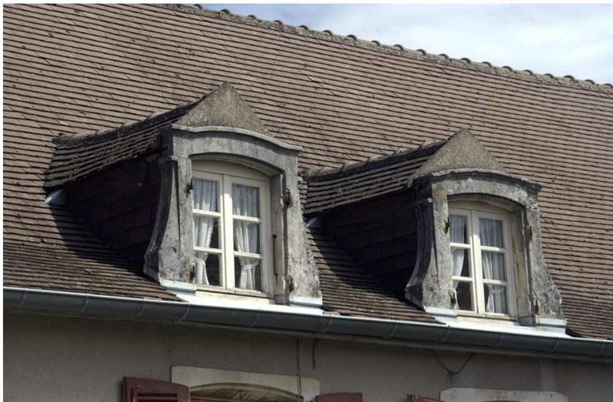
Façade antérieure, détail des lucarnes.
