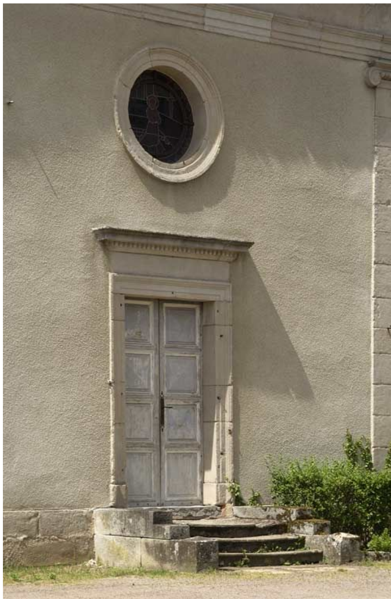
Porte de la chapelle surmontée d'un oculus.
