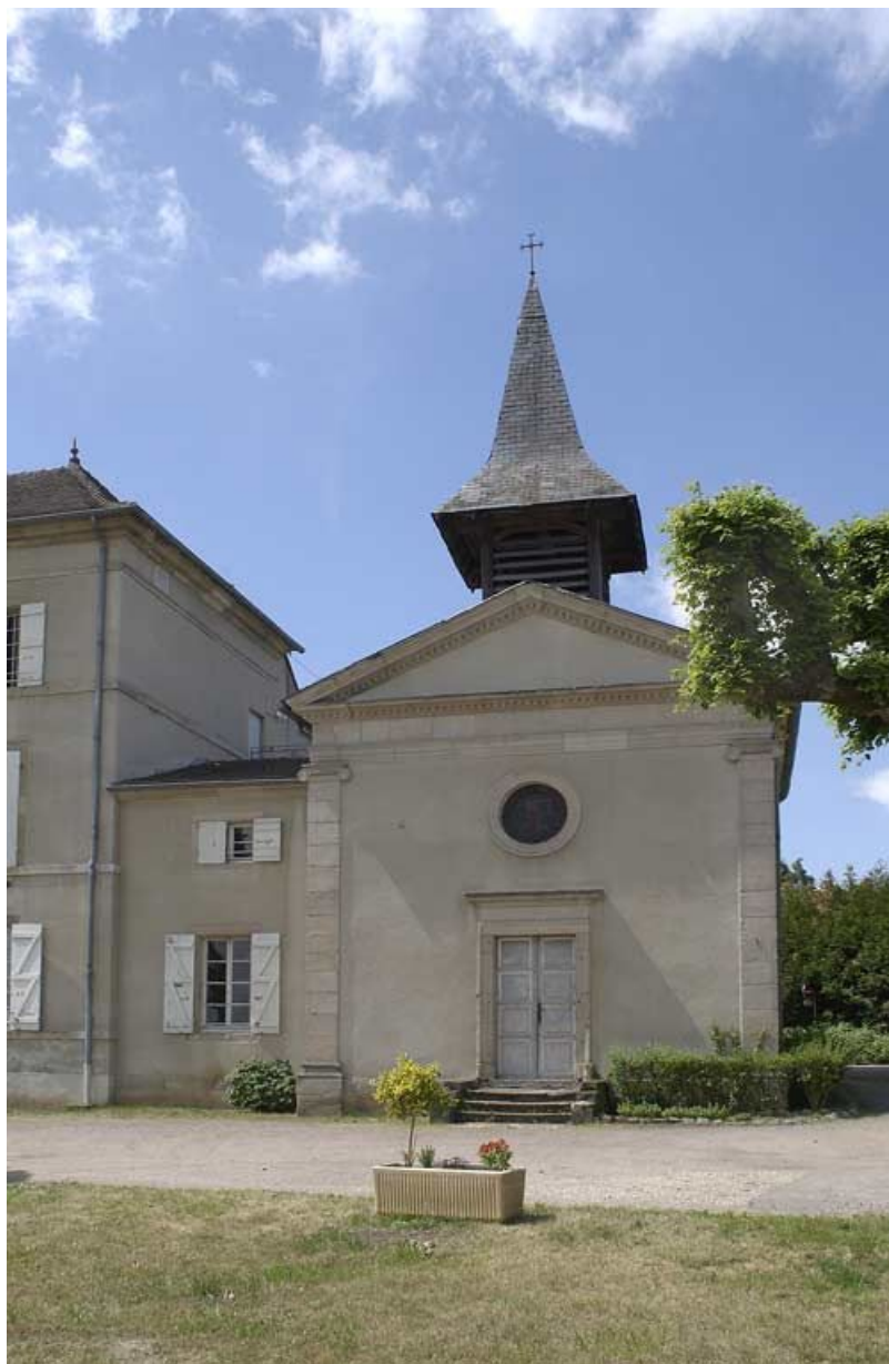
Façade antérieure de la chapelle.
