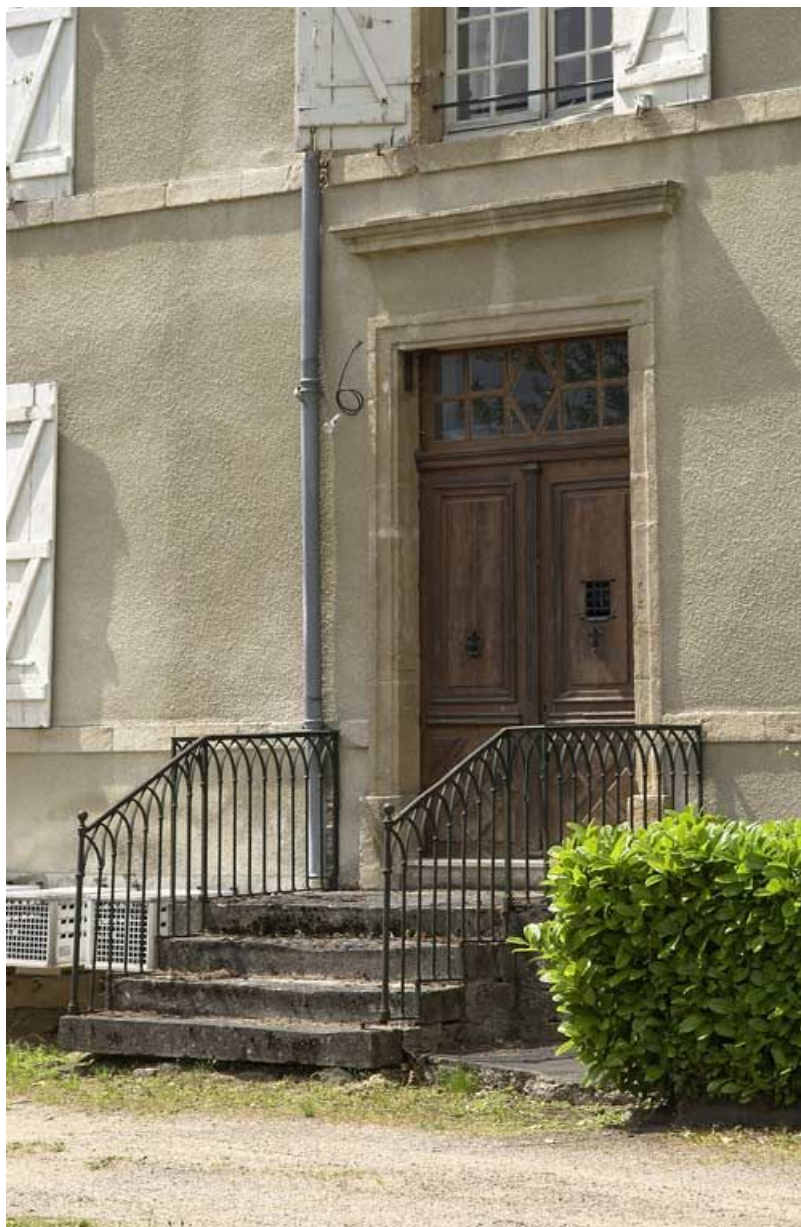
Détail de la porte d'entrée sur la façade antérieure.
