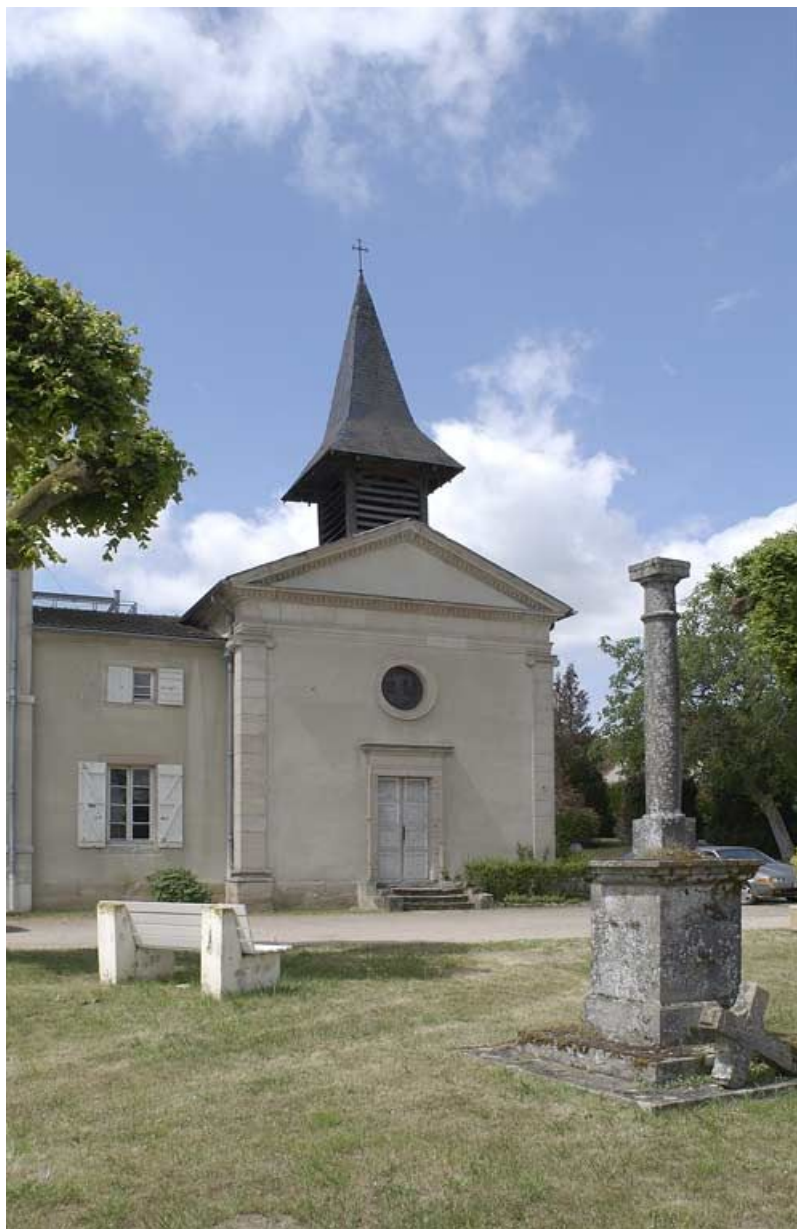
Façade antérieure de la chapelle et croix.
