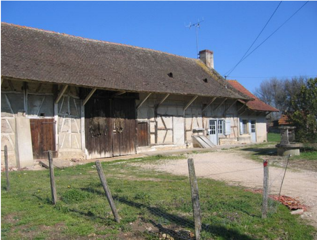
Vue d'ensemble de la façade.
