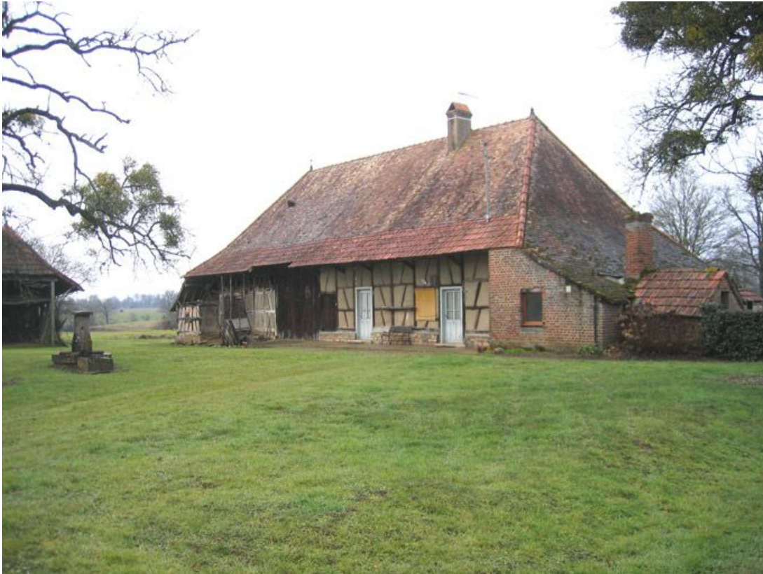
Vue d'ensemble de la façade.
