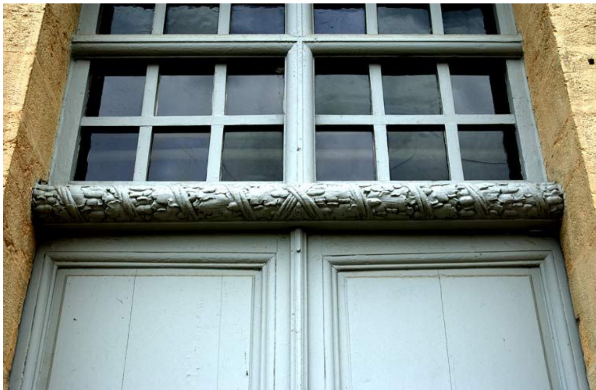
Aile gauche, détail de l'imposte de la fenêtre surmontant la porte d'entrée. 71, Cluny, 13 place de Hôpital
