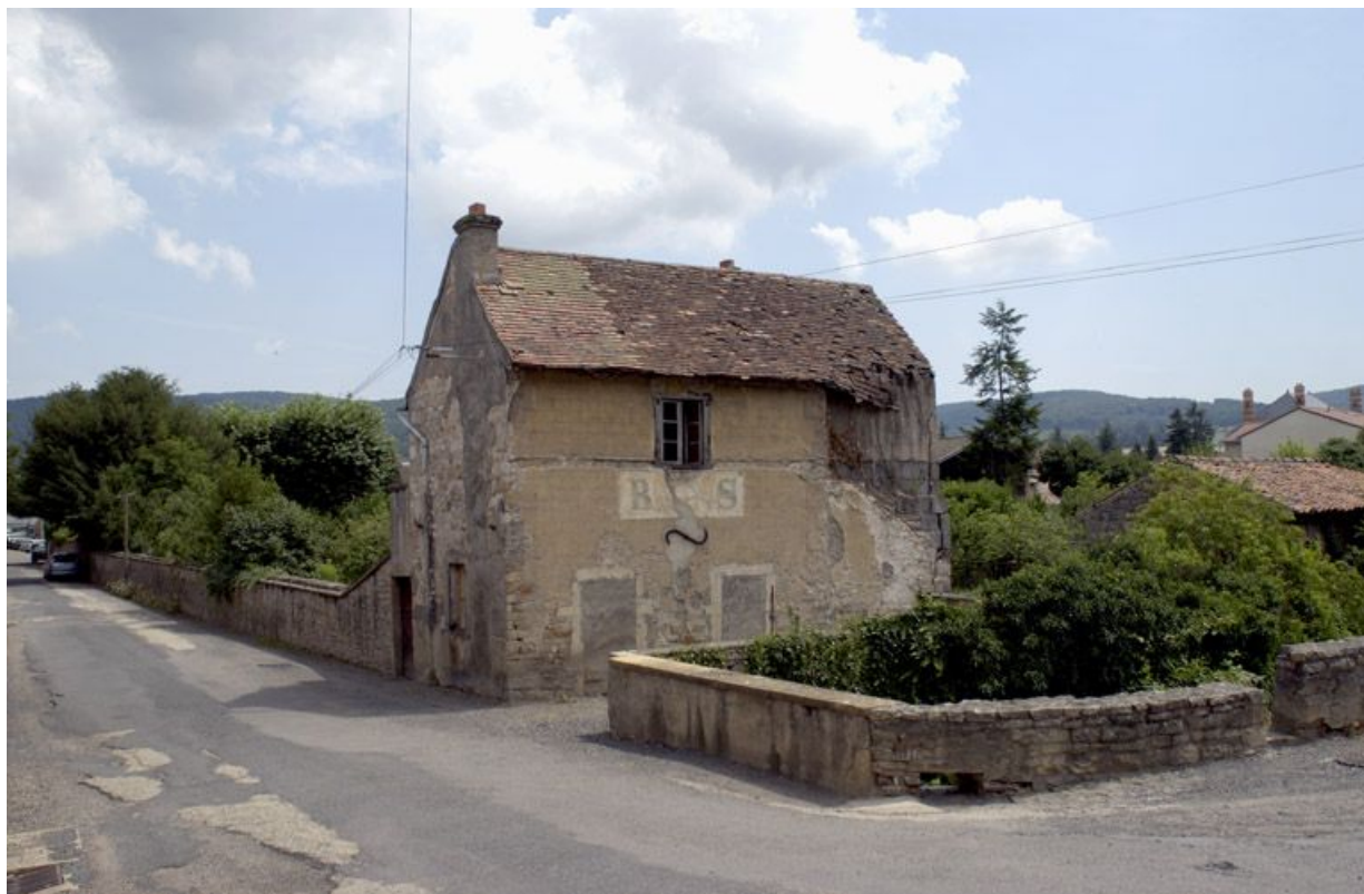
Anciens bains publics, bâtiment désaffecté.
