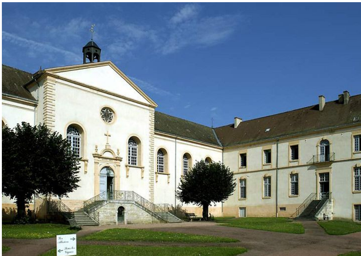
Façade antérieure du bâtiment principal et aile droite.
