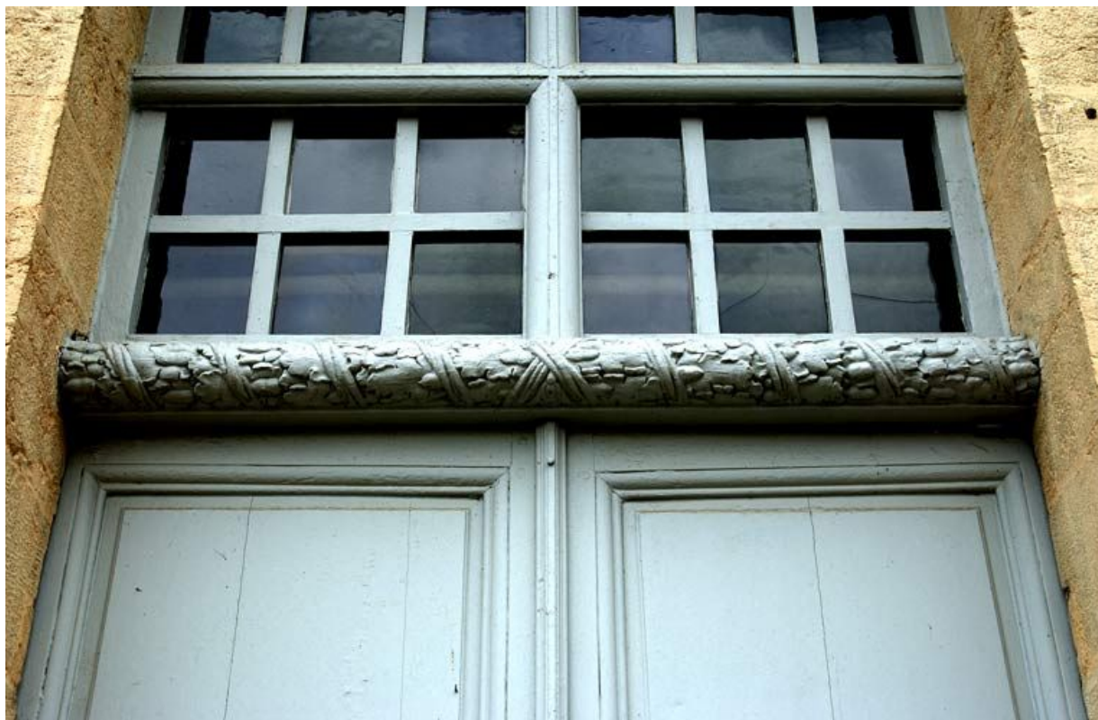
Aile gauche, détail de l'imposte de la fenêtre surmontant la porte d'entrée.
