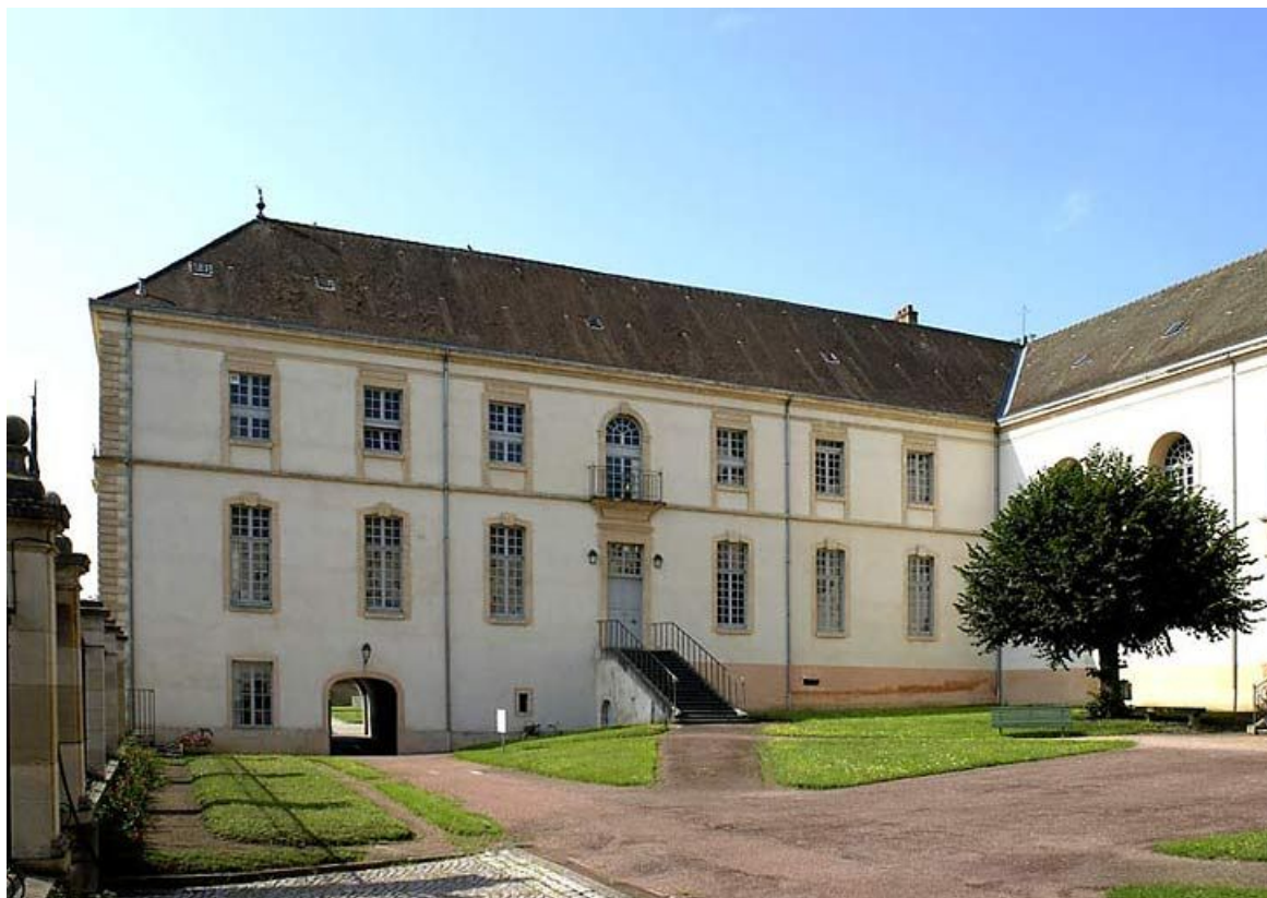
Aile gauche (sud), façade antérieure.
