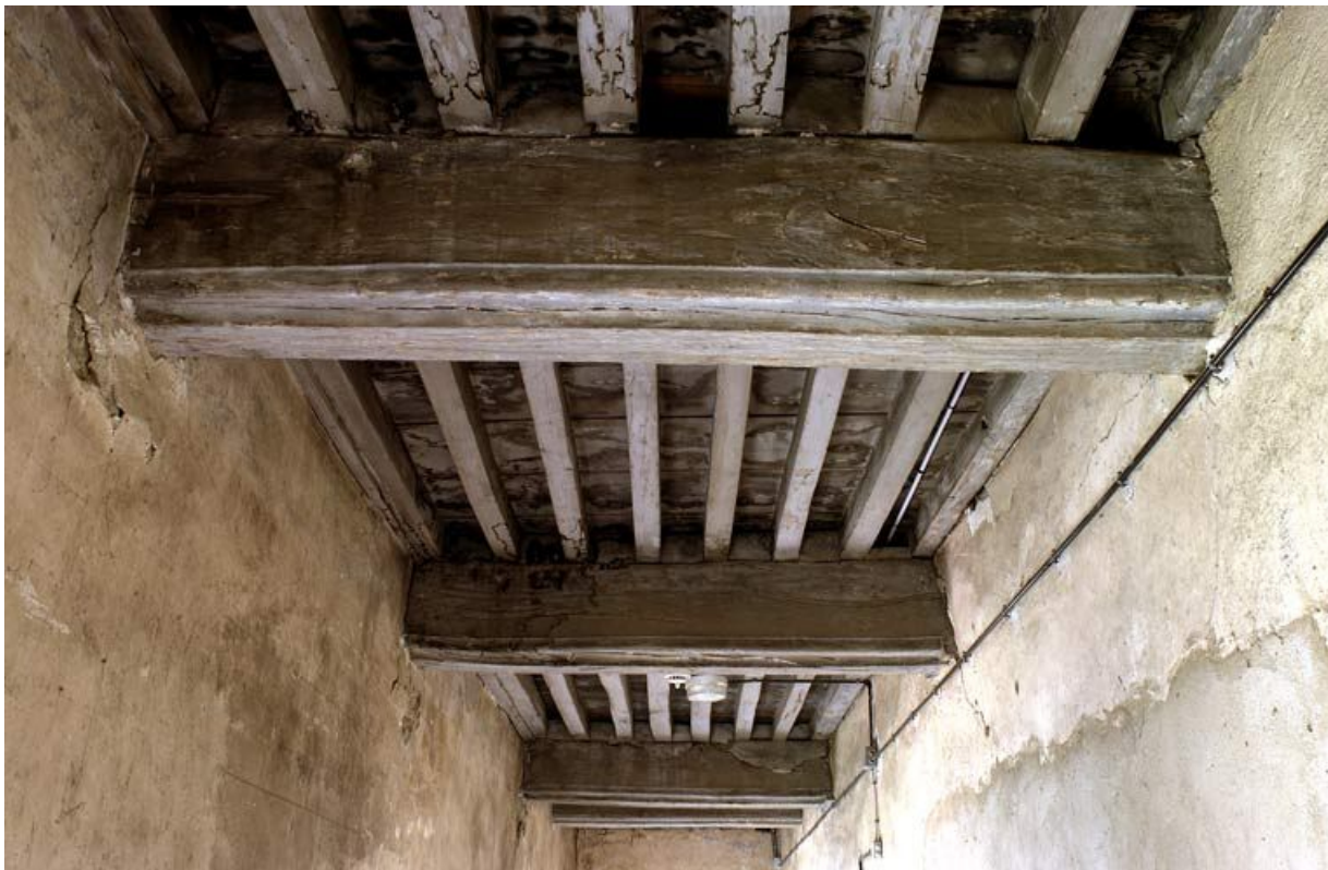
Etage de comble de l'aile gauche, détail du plafond.
