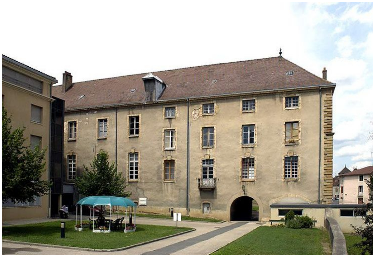
Aile gauche, façade postérieure.
