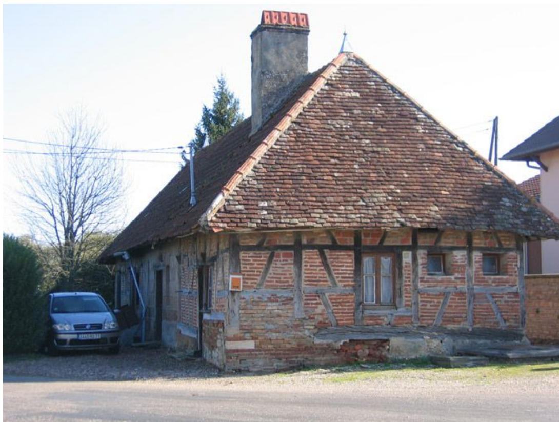
Vue d'ensemble de la façade.
