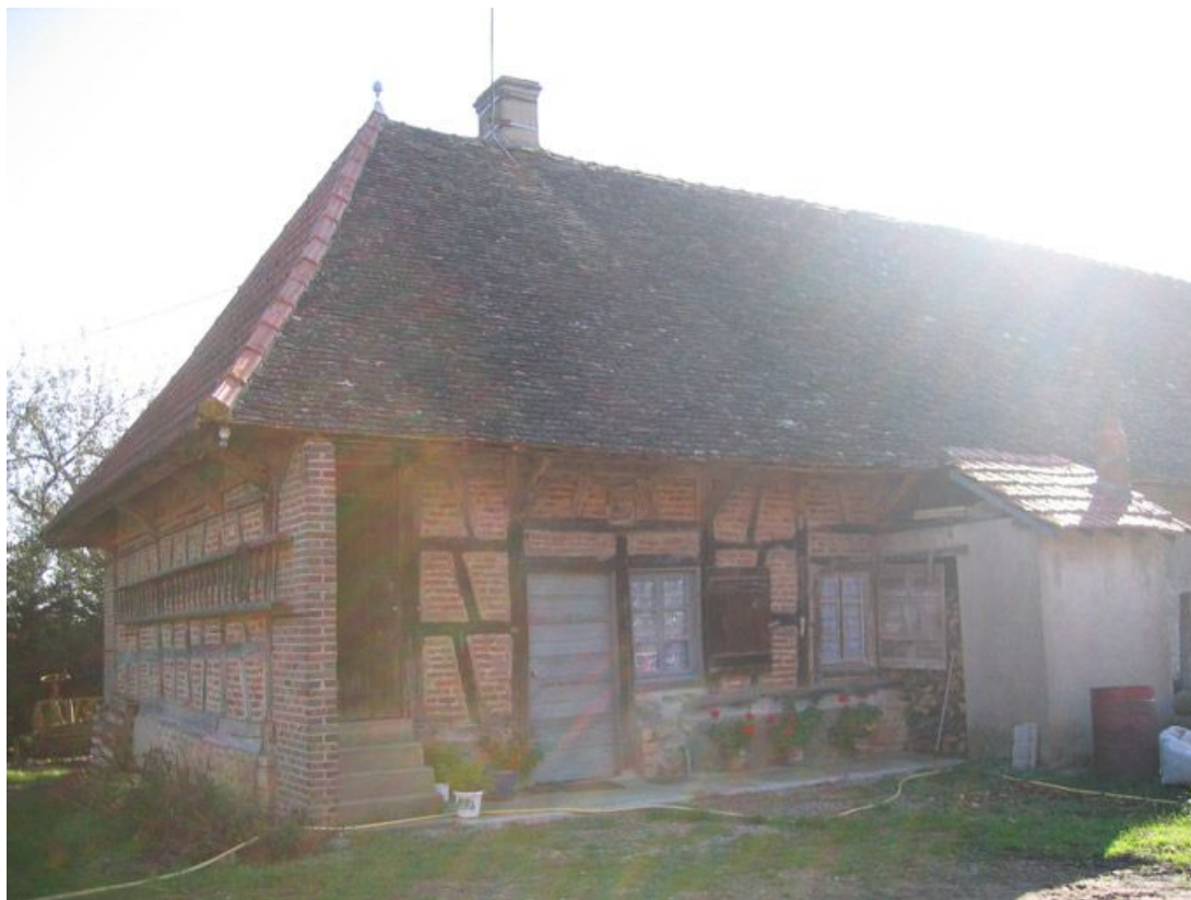
Vue d'ensemble de la façade de l'habitation.
