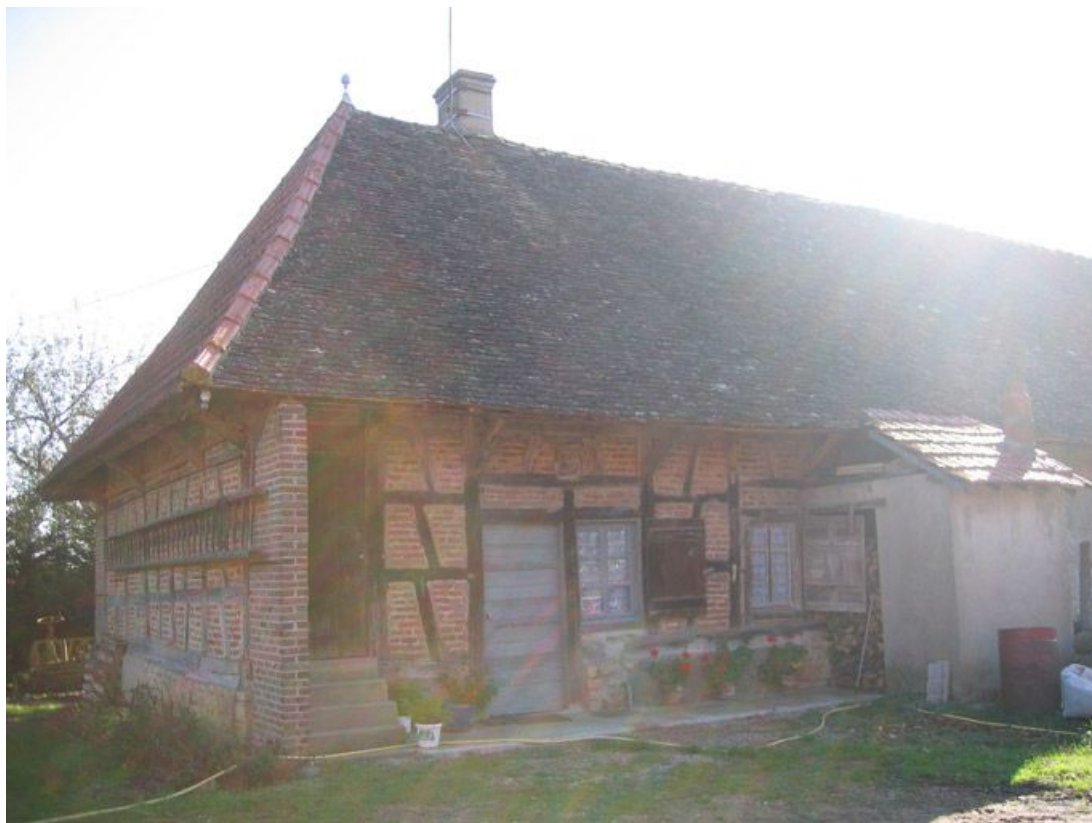
Vue d'ensemble de la façade de l'habitation.
