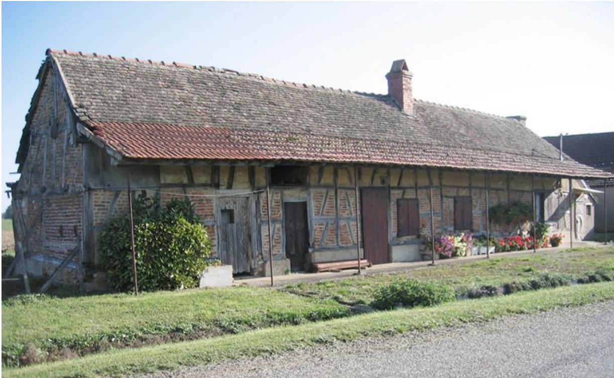
Vue d'ensemble de la façade.
