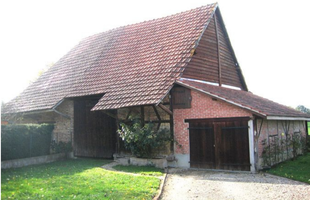
Vue d'ensemble de la façade du bâtiment des dépendances.
