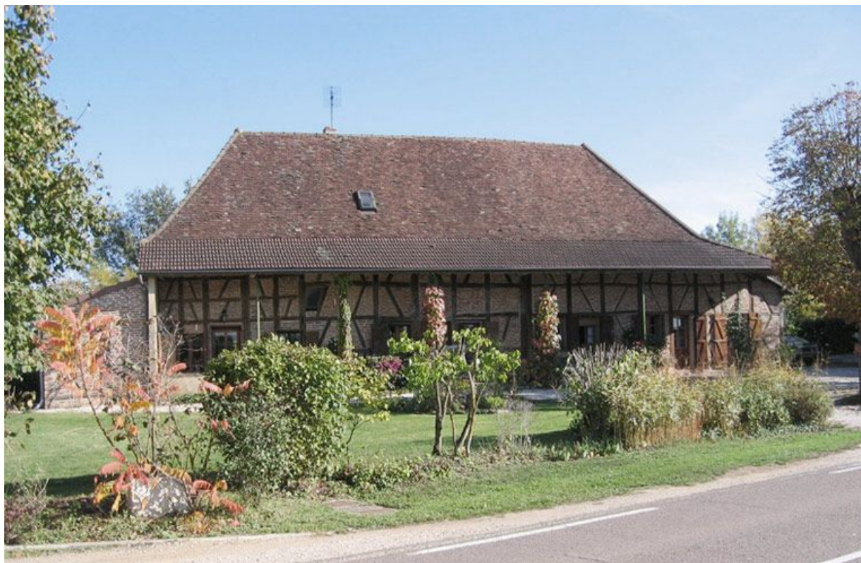
Vue d'ensemble de la façade.
