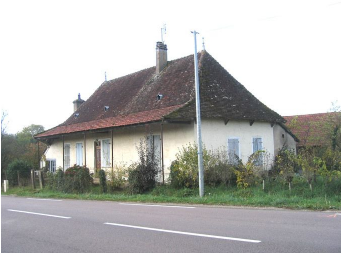
Vue d'ensemble de la façade de l'habitation.
